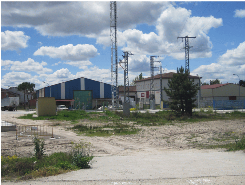
FOTOGRAFÍA 25. Vista del polígono industrial “Dehesa Boyal”, al Noroeste del núcleo, único Sector de Suelo Apto para Urbanizar desarrollado desde la aprobación de las NSM en 1995
