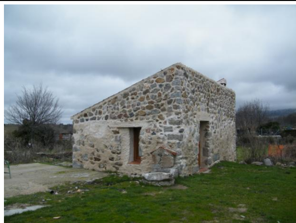
Vista del exterior de la fragua
