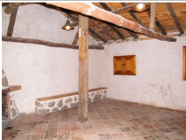
Vista del interior de la casa del Vaquero
