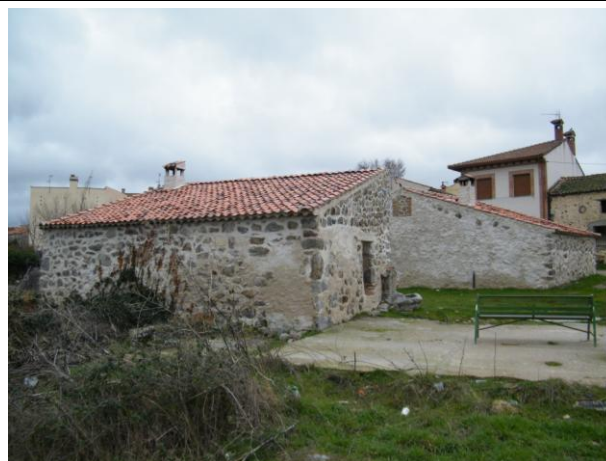
Vista del conjunto, en primer término la trasera de la fragua
