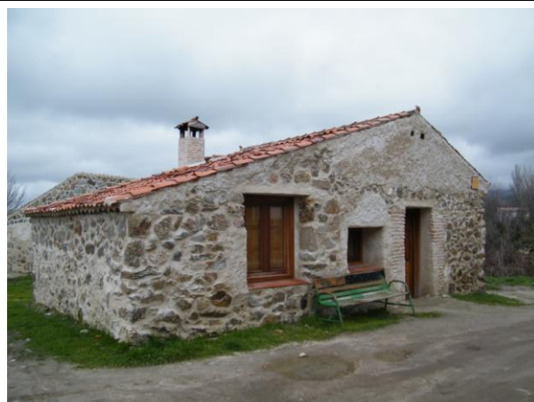
Vista exterior de la Casa del Vaquero
