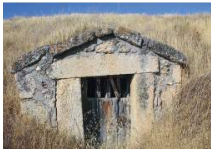
Fachada rematada en frontón.
