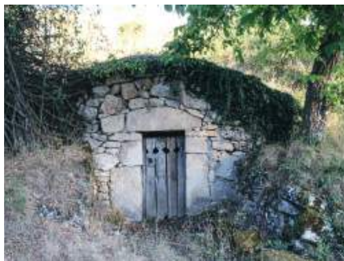
Fachada de bodega.
