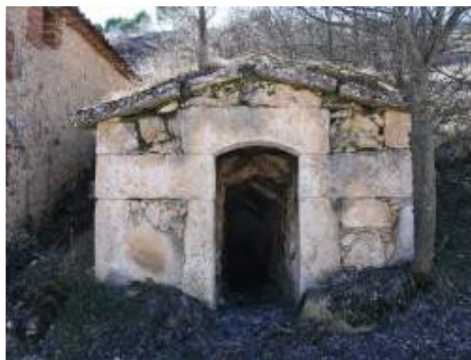
Entrada con dintel en arco rebajado.
