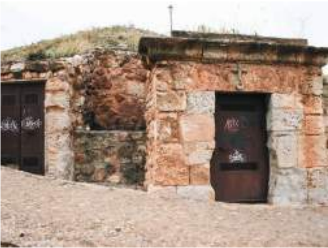
Bodega con lagar subterráneo. El descargadero cerrado con la puerta de la izquierda.
