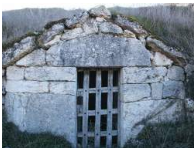
Fachada rematada en frontón triangular.
