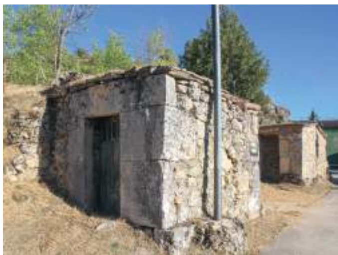
Bodegas con contador.
