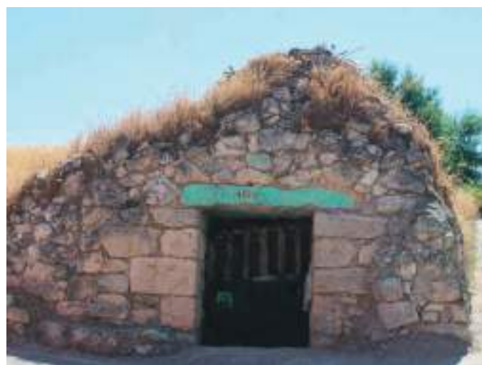
Bodega del grupo oeste construida en 1936.
