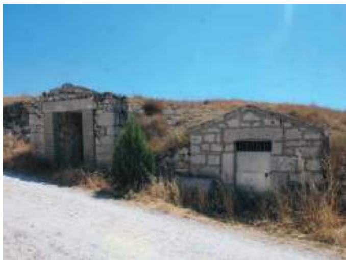
Bodegas del segundo grupo del este.
