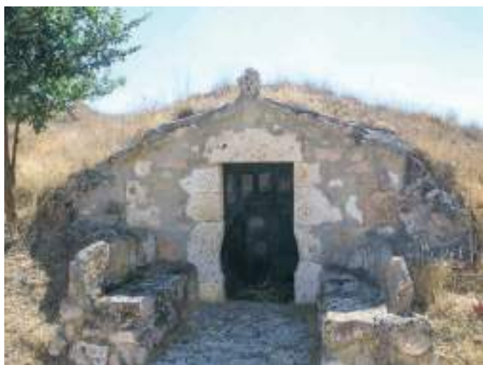
Fachada curvada siguiendo toda la superficie del lomo.
