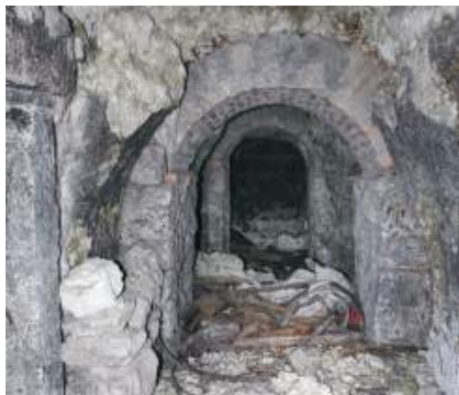
Bodega con arcos de refuerzo.
