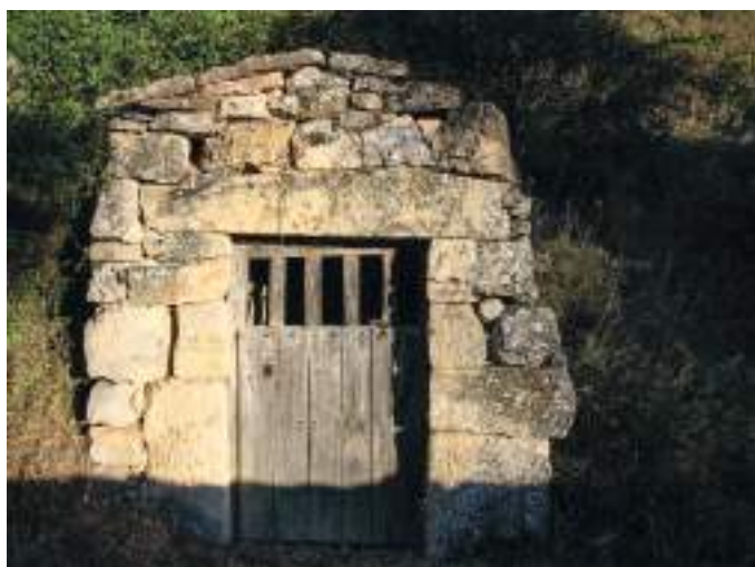
Fachada de bodega.
