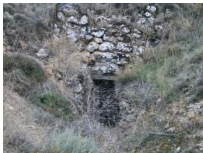
Puertas con muretes de contención.
