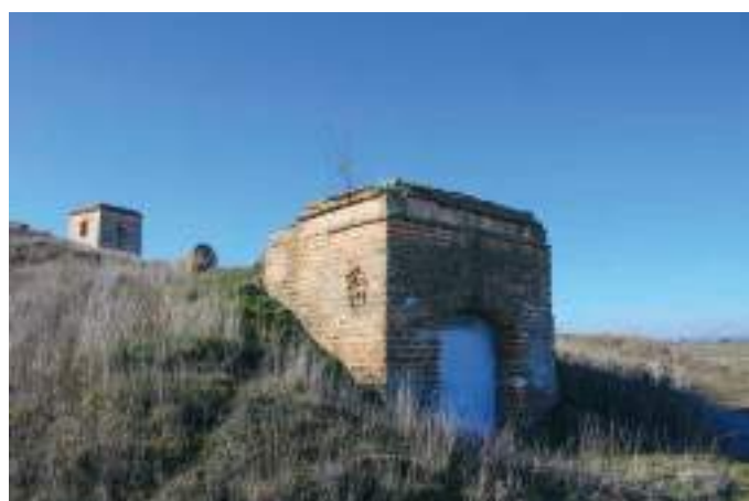
Bodega con 'contador' y zarcera. Torre del telégrafo óptico al fondo.
