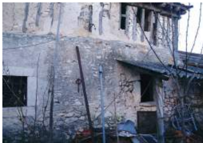
Lagar construido en el interior de una vivienda.
