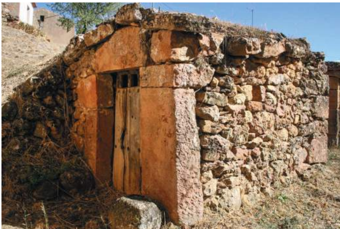
Contador con fachada de sillares y resto de mampostería.
