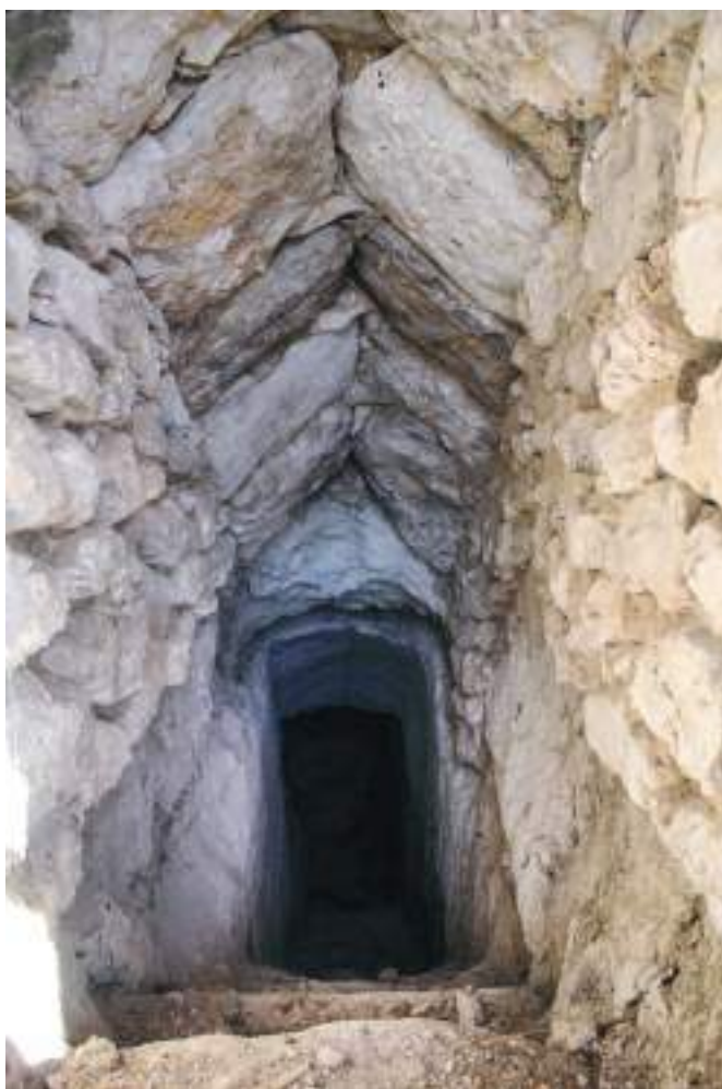
Cañón con bóveda mitrada y paredes de mampostería.
