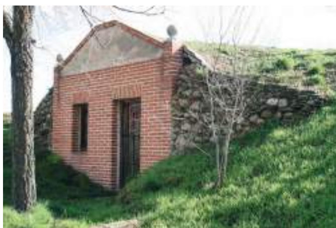
Bodega con fachada nueva.
