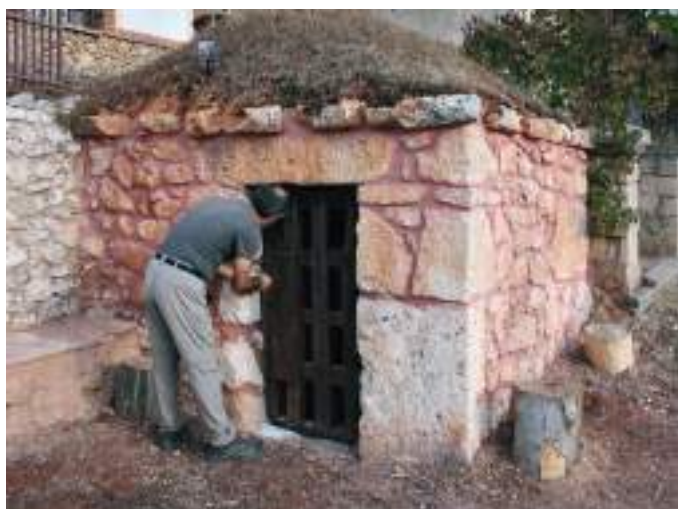
Bodega con contador.
