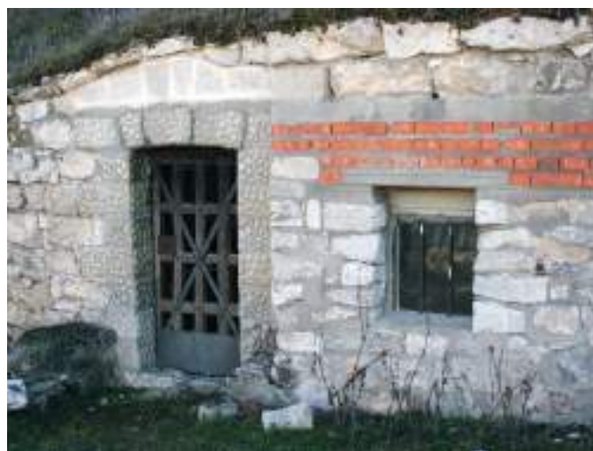
Acondicionamiento de fachada en diferentes épocas.
