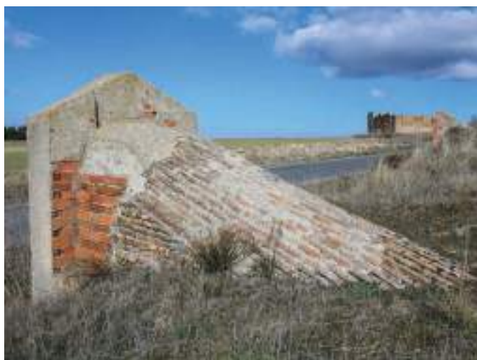
Vista exterior del 'vestíbulo' y 'cañón'.
