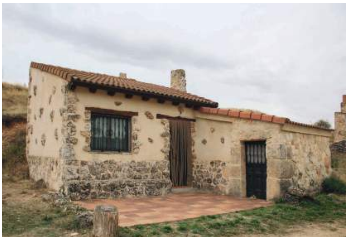
Bodega merendero y bodega con contador.
