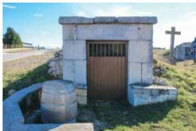
Bodega con fachada adintelada.
