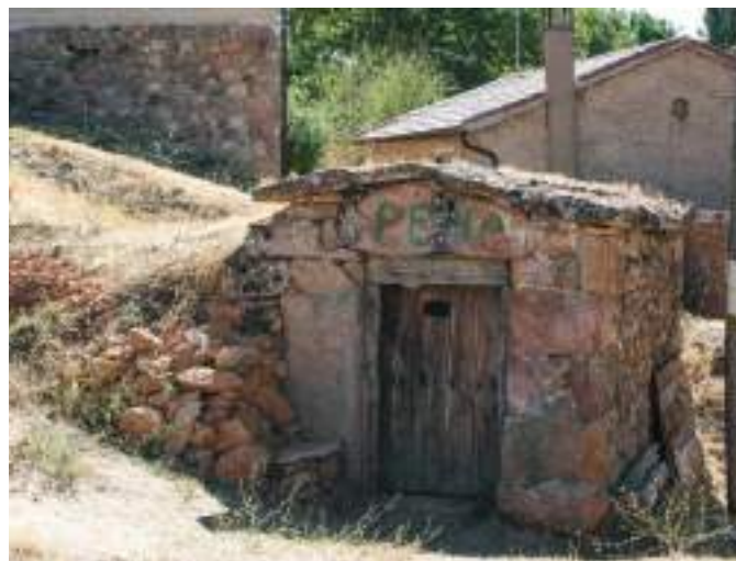
Caseta con techo de lajas.
