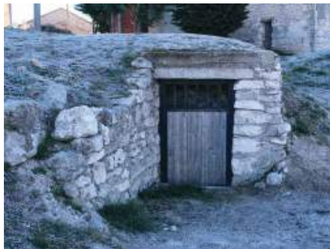
Bodega con 'contador'.
