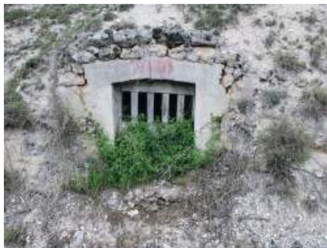
Bodega del grupo sur construida en 1947.
