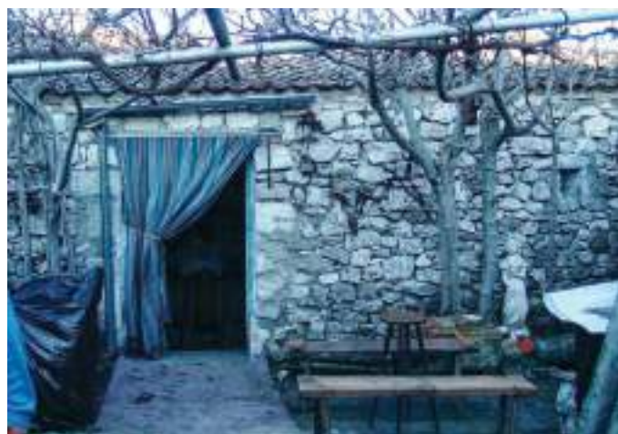
Lagar construido dentro de un corral.
