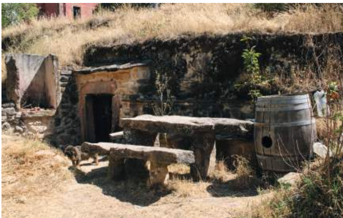
Bodega excavada bajo un afloramiento rocoso.
