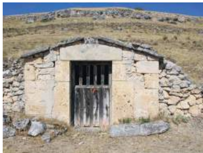
Característica fachada de sillar y muretes de piedra en seco.
