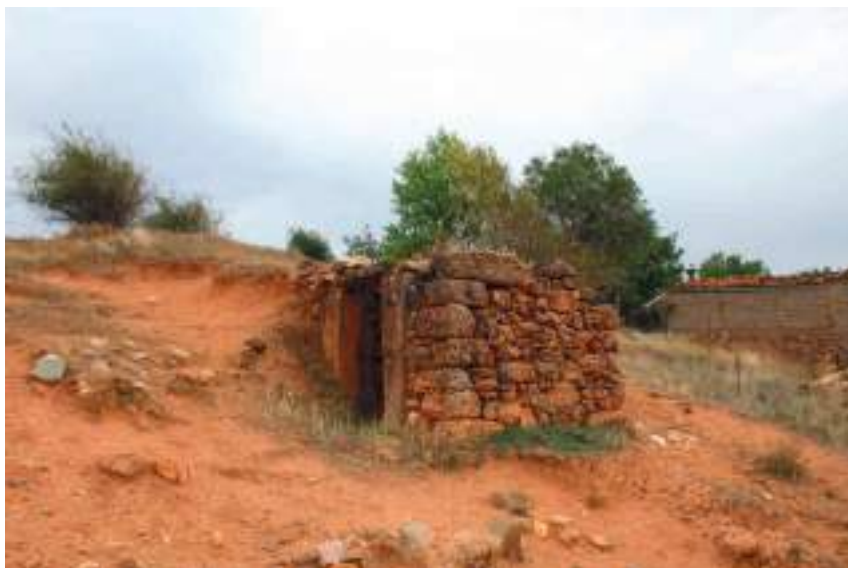
Bodega con contador.
