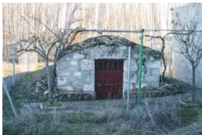
Fachada rematada en frontón.
