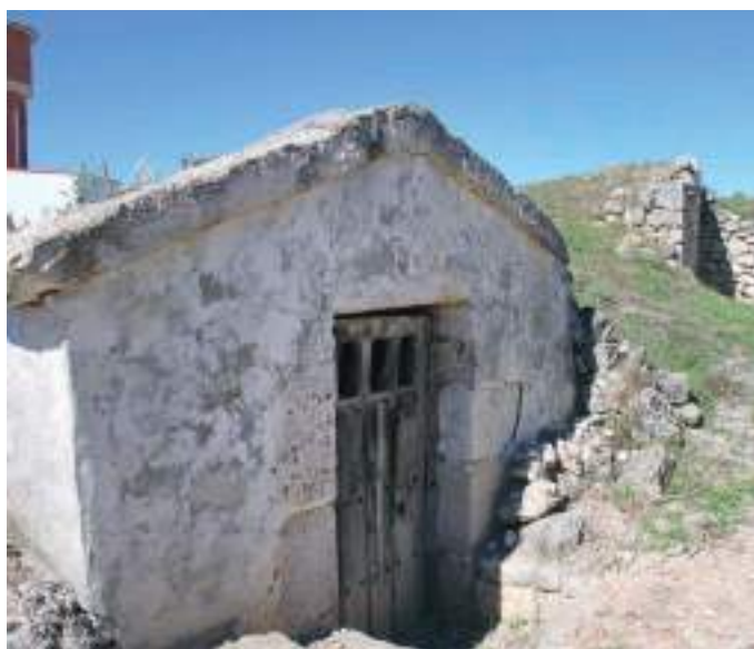
Distribución de bodegas en la ladera.
