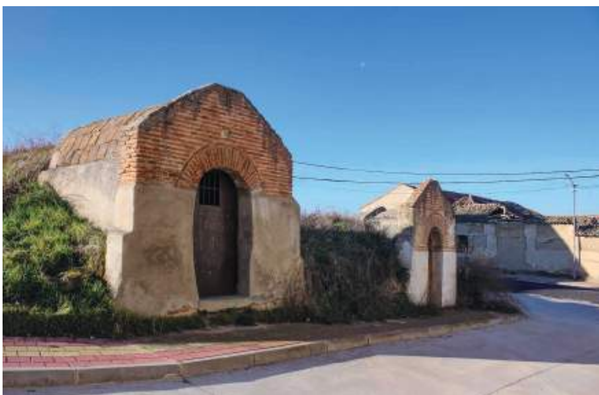
Fachadas con puerta en arco de medio punto y remate en frontón truncado.
