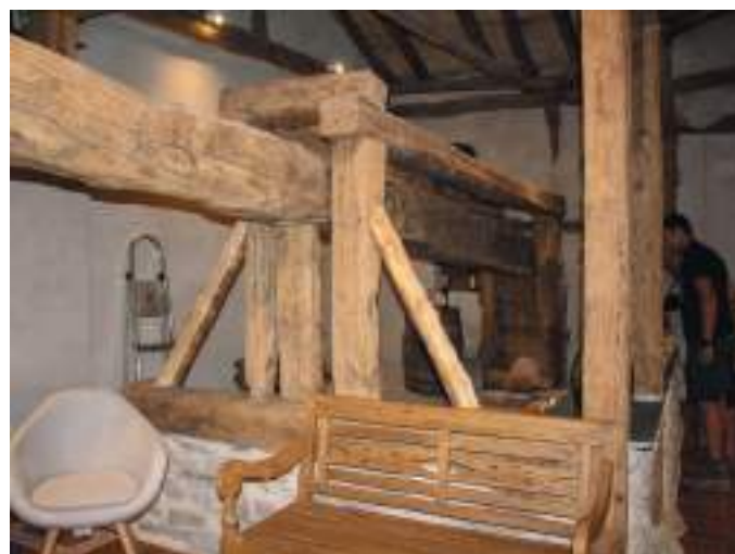
Viga y espacio de la pila.
