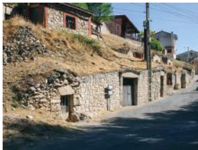
Vista de la zona de bodegas desde la carretera.
