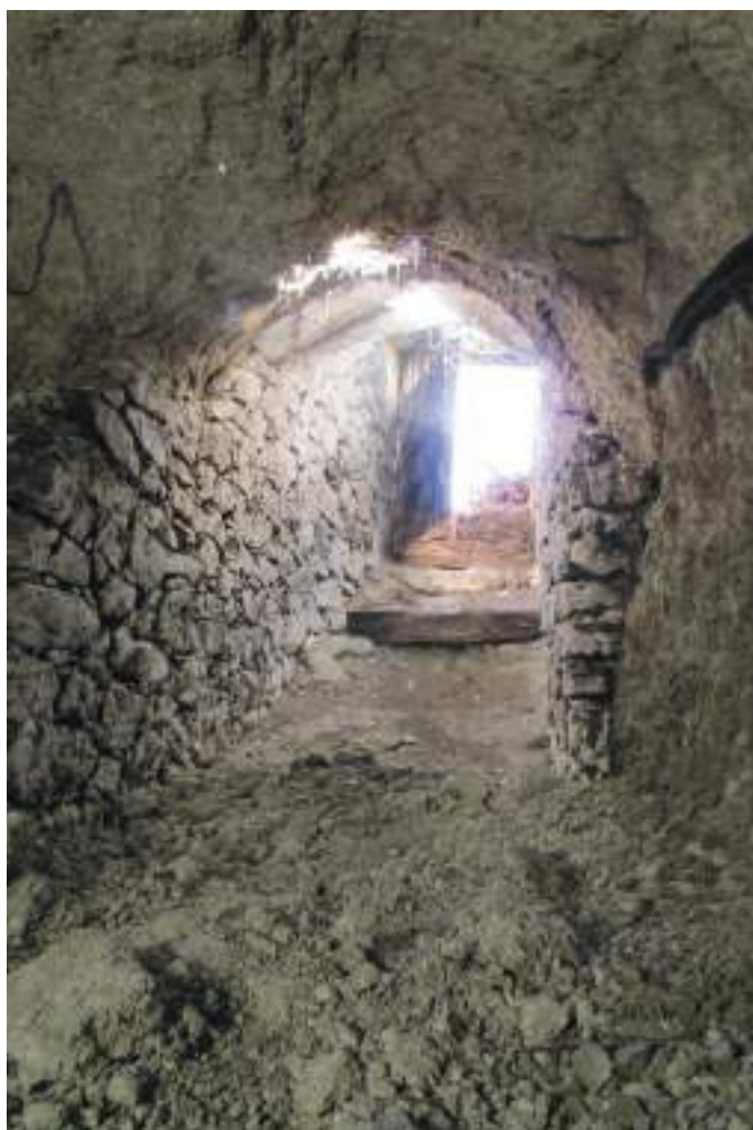
Cañón de la bodega n.º 3, con vista hacia la salida.
