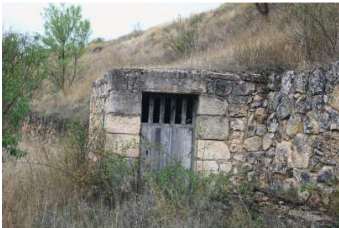
Bodega con contador.
