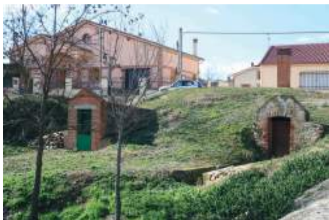
Bodegas excavadas al pie de la charca.
