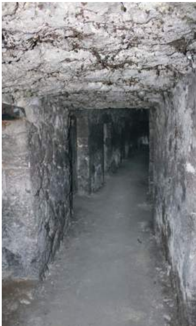
Pasillo con techo plano.
