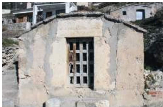
Fachada con frontón truncado y un gran sillar para cada jamba y el dintel.
