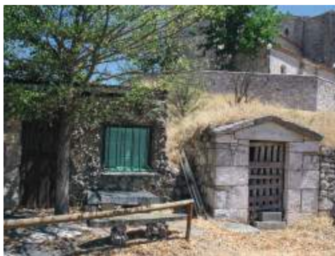
Bodega con casilla y bodega de entrada directa.
