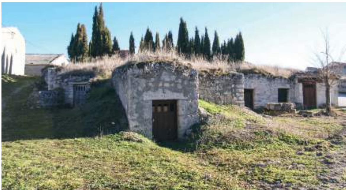
Vista parcial de la zona de bodegas.
