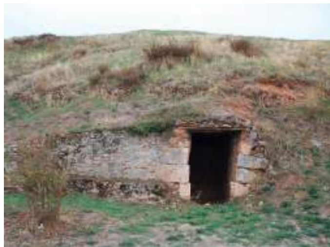
Bodegas con fachada de sillares y mampostería.
