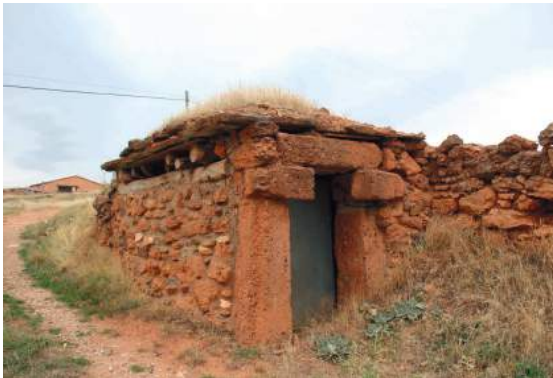
Contador con bloques monolíticos.
