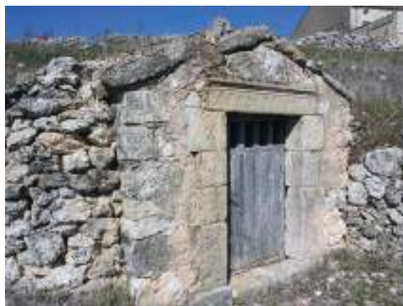
Fachada con dintel fabricado a molde.
