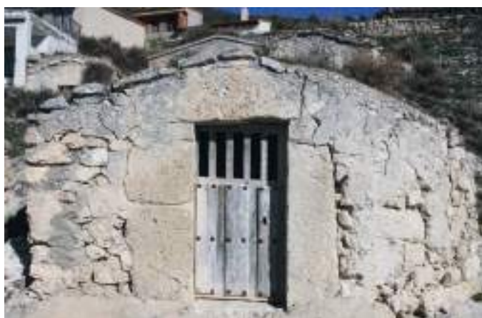
Edificio rectangular con frontón triangular.
