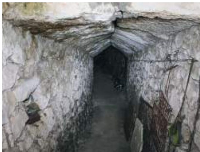
'Cañón' en mampostería y bóveda mitrada.
