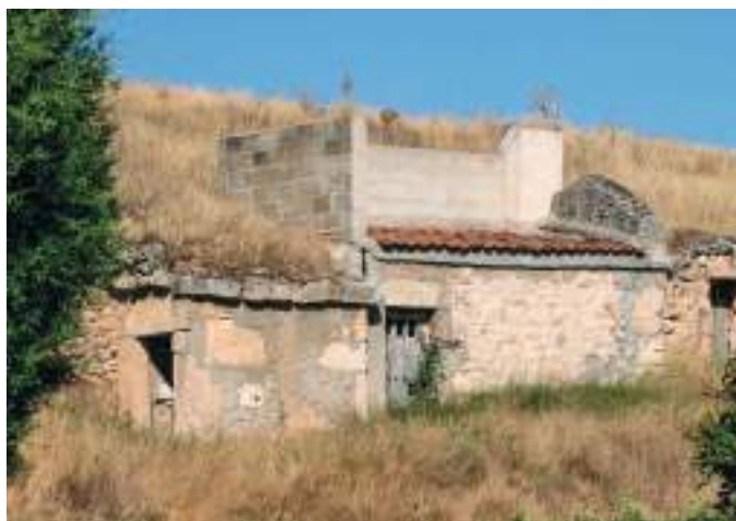
Bodega con entrada en codo, lagareta y bodega con entrada frontal.
