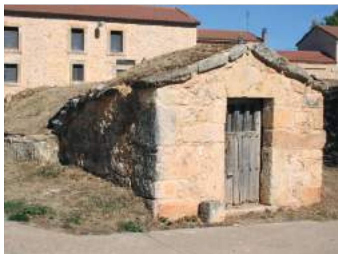
Bodega con fachada rematada en frontón y cañón visto.
