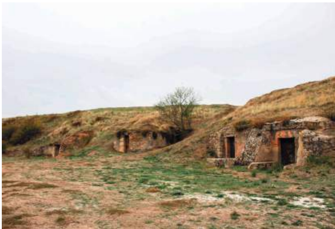
Barrio de bodegas excavadas en el espigón del castillo.
