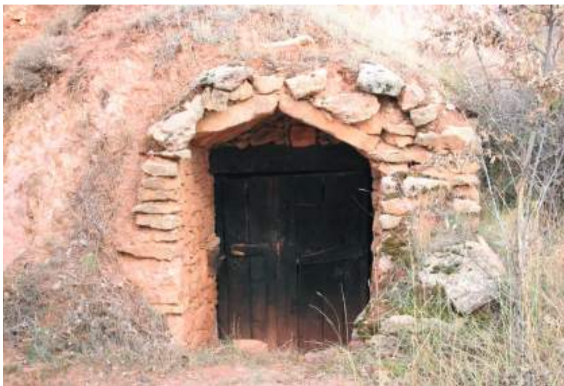
Bodega en el barrio de Los Terreros, de fachada simple y con la estructura del cañón prolonga al exterior de la puerta.
