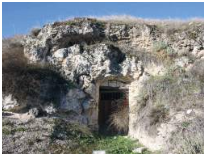
Bodega excavada bajo un estrato de roca.
