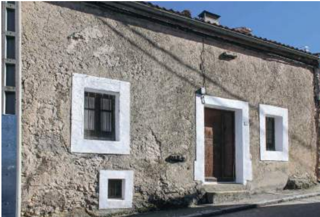
Vivienda con el ventanuco de ventilación de la bodega semisubterránea en la fachada.
