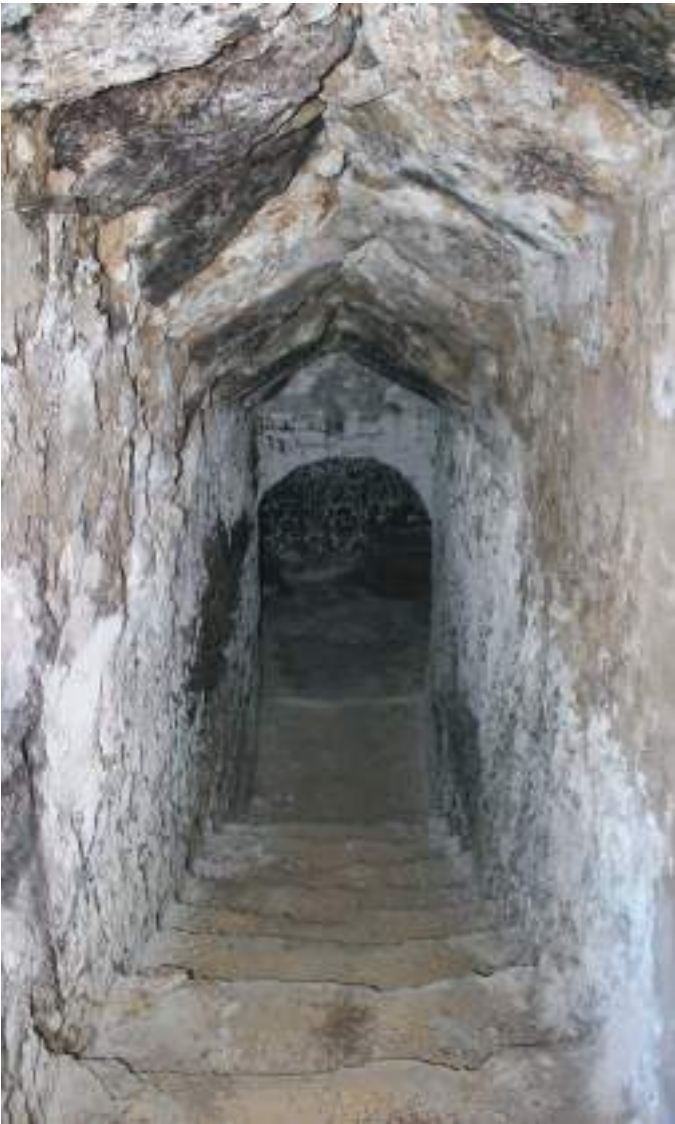
Cañón con escaleras y bóveda mitrada.
