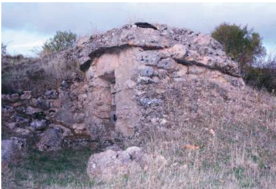
Bodega con contador.
