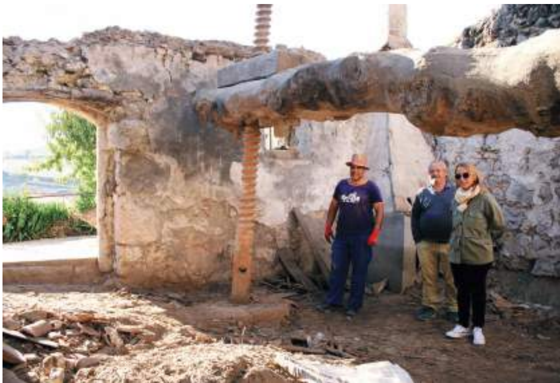
Lagar en rehabilitación.
