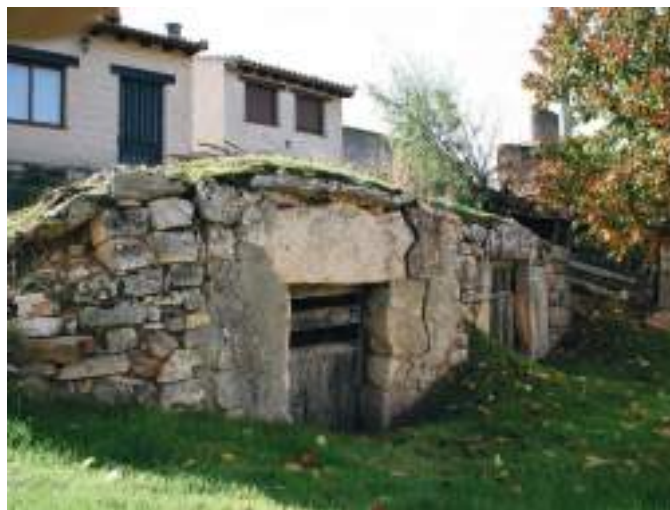
Bodegas de entrada simple y bodegas con merendero de nueva construcción.
