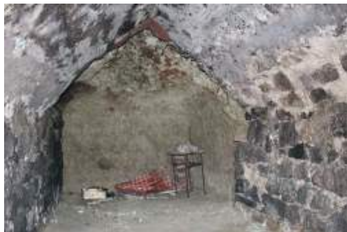
Bodegón con bóveda reconstruida.
