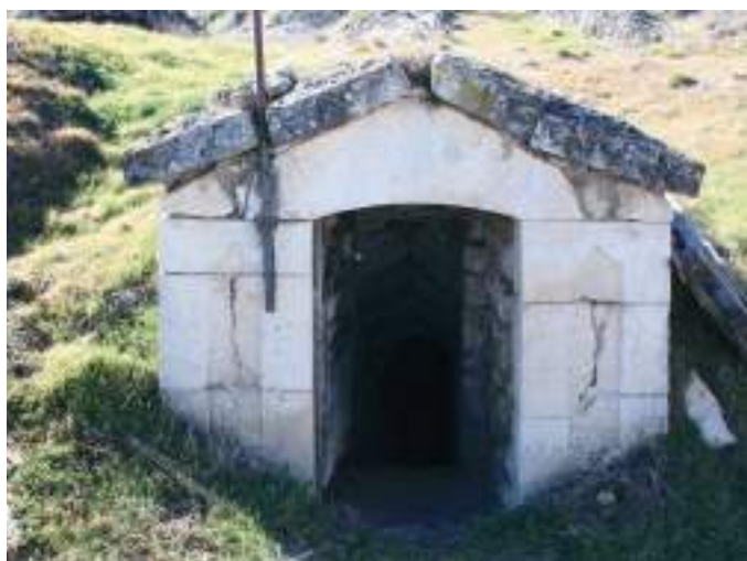
Fachada construida con sillares con decoración.
