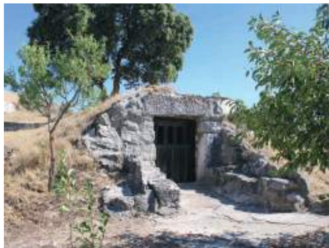
Bodega con fachada adintelada.
