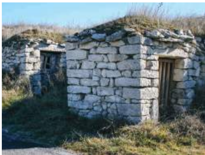
Bodegas con 'contador' y entrada en ángulo recto.
