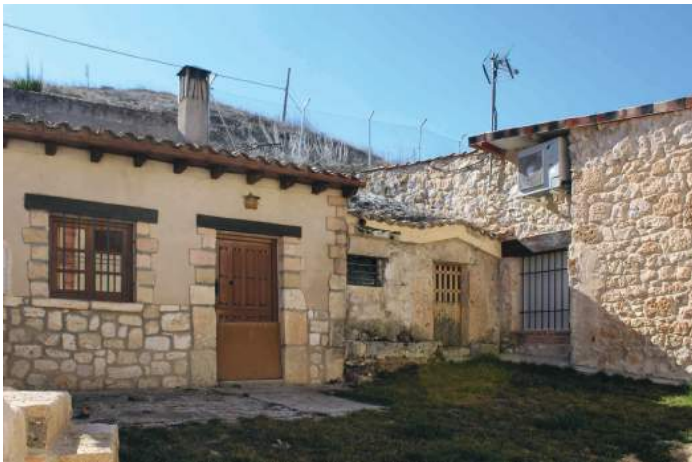
Bodega con casilla-merendero.
