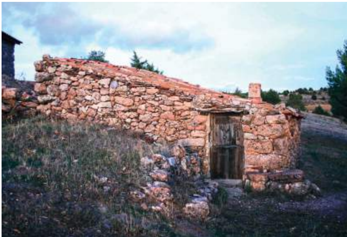
Bodega con casilla y entrada en codo. Posiblemente sea una lagareta.
