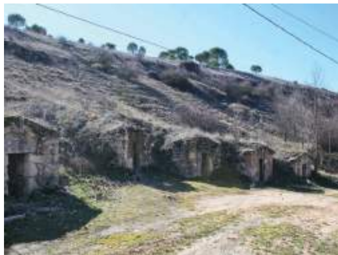
Hilera de bodegas en la base de la ladera sur.
