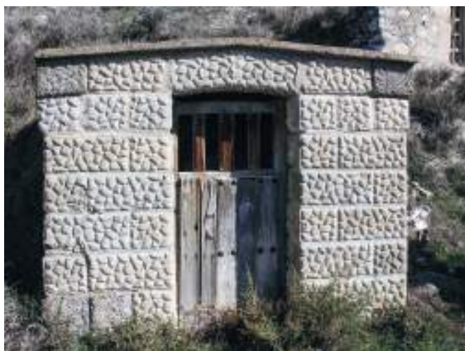
Fachada construida con materiales fabricados en molde.
