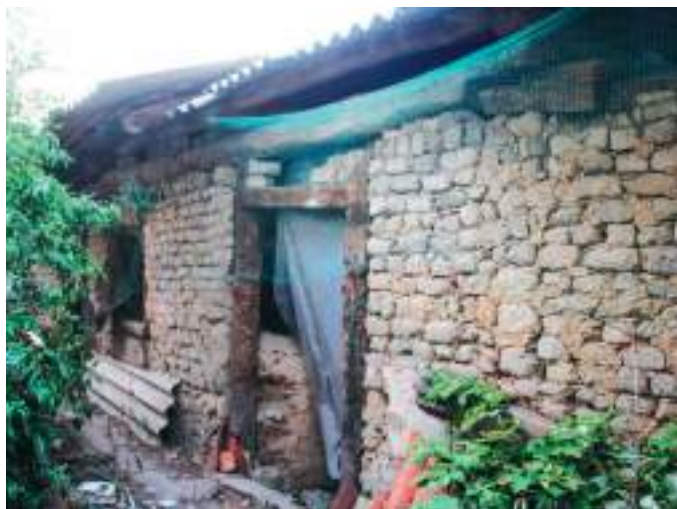
Exterior del primer lagar visitado.
