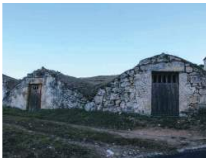
Fachadas que siguen la curva del lomo.
