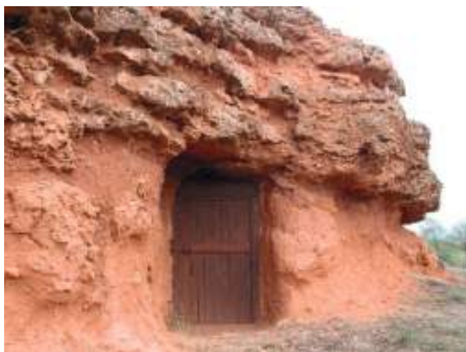
Bodega excavada en la arcilla bajo la arenisca.
