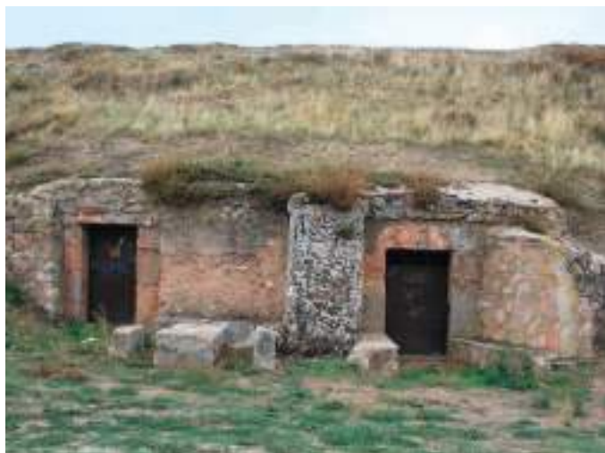
Bodegas con fachada de sillares y mampostería.
