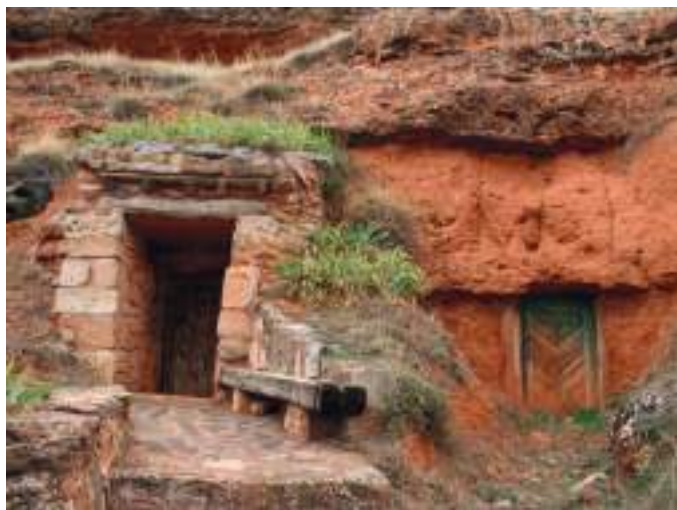
Bodegas con fachada de sillarejo y de puerta simple.
