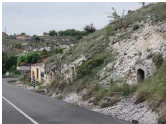
Grupo de bodegas de la ladera sur.
