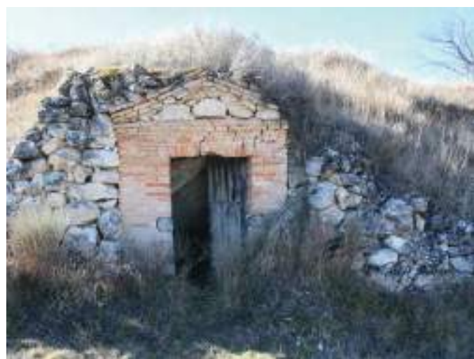
Fachada con diferentes materiales constructivos.
