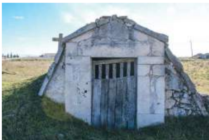
Fachada simple con muretes de contención.
