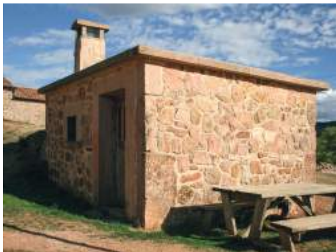
Bodega con casilla-merendero.
