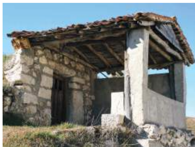
Bodega con antefachada.
