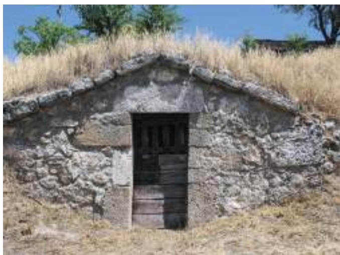
Bodega con fachada prolongada.
