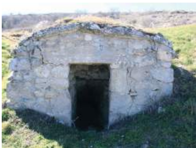
Bodega construida probablemente en 1902.
