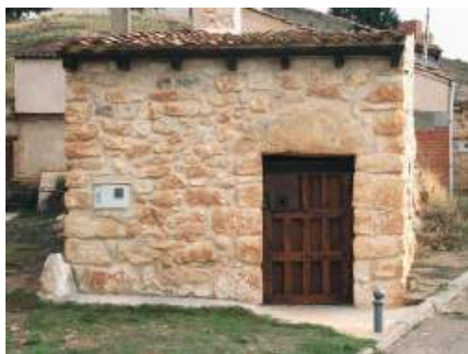
Bodega con casilla-merendero.
