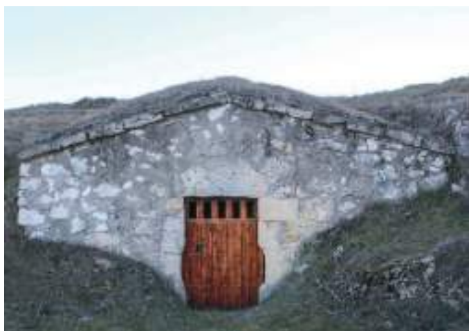
Fachada con frontón triangular y rebaje en las jambas para el paso de las cubas.
