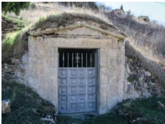
Fachada construida con materiales fabricados con molde.
