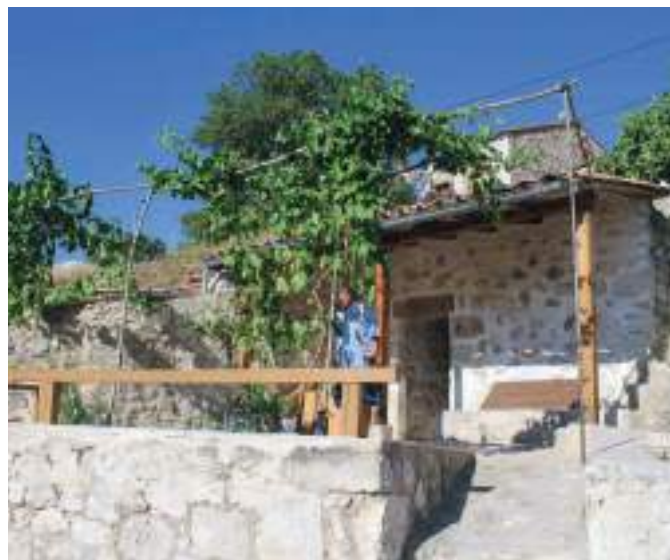
Fachada rehecha de bodega con entrada a nivel de calle.
