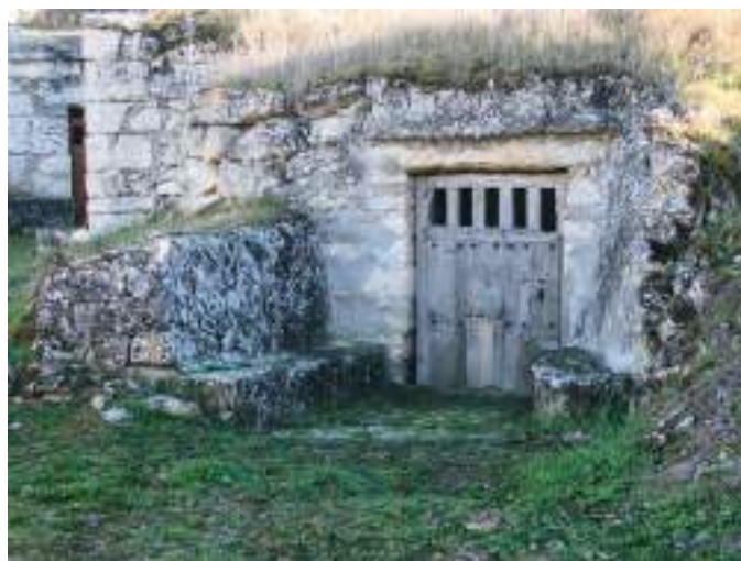
Bodega con antefachada.
