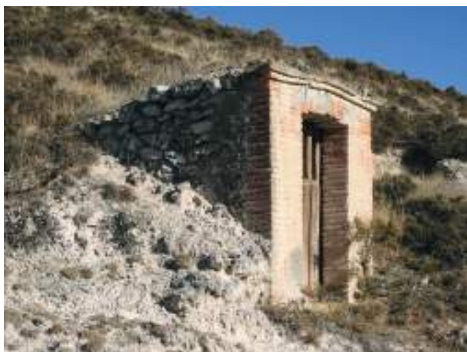
Bodega mixta construida con ladrillo y mampostería.
