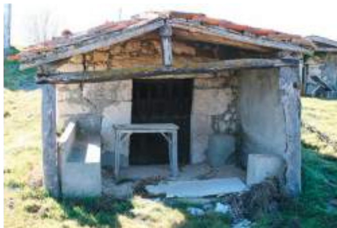
Membibre de la Hoz. Antefachada de bodega.
