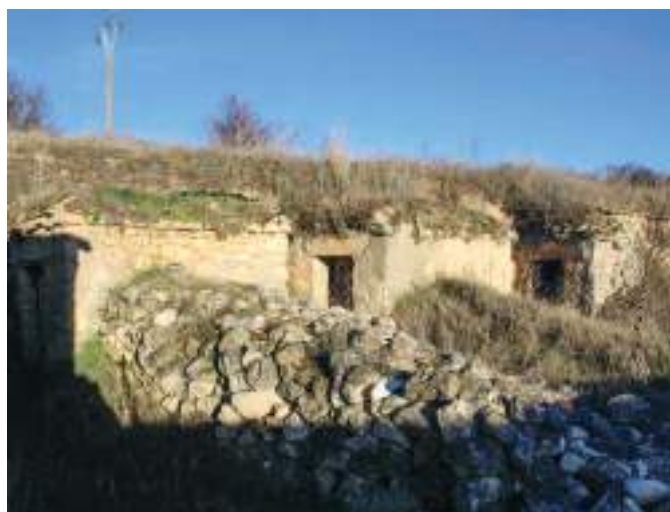
Bodegas con contador.
