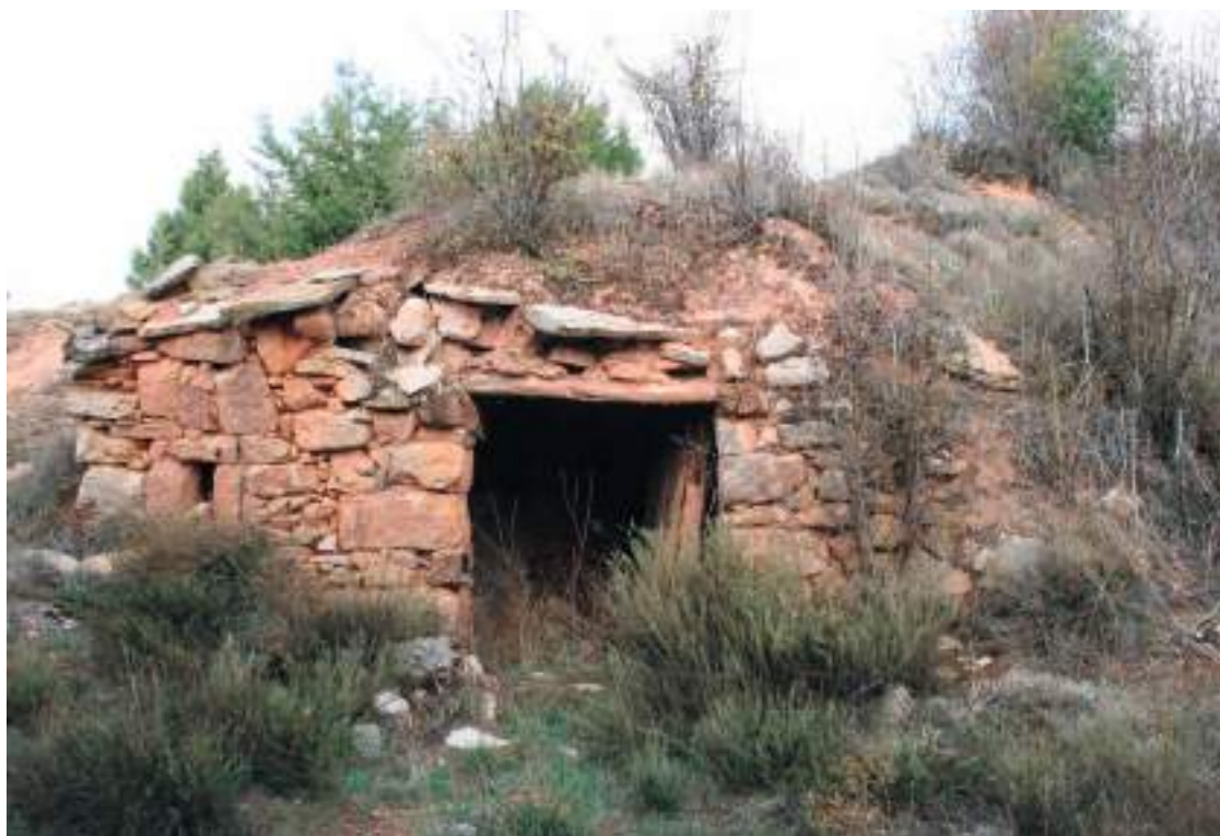
Bodega con contador en el barrio de Los Terreros.
