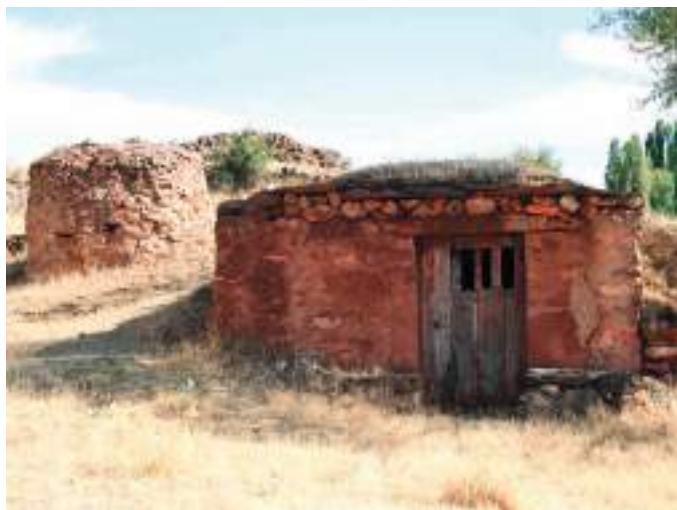
Bodega con contador y zarcera.
