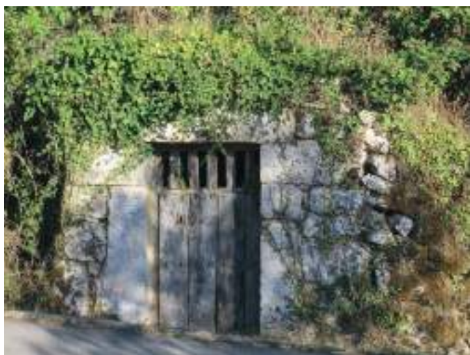
Fachada típica de sillares y mampostería.
