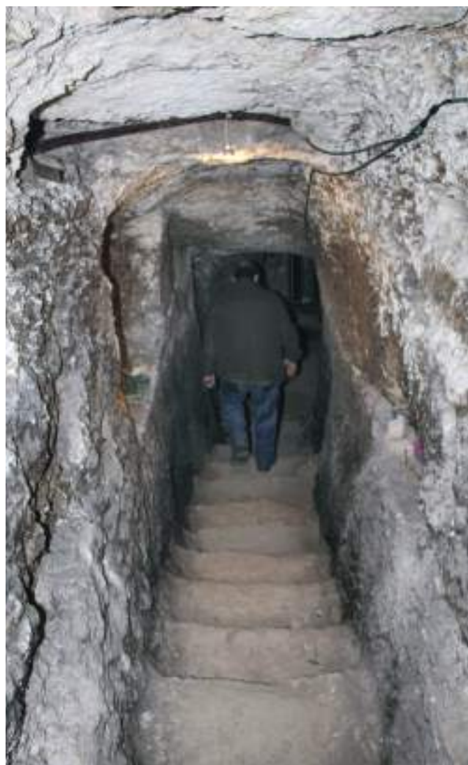
Segundo tramo del cañón excavado en la roca en bodega anterior.
