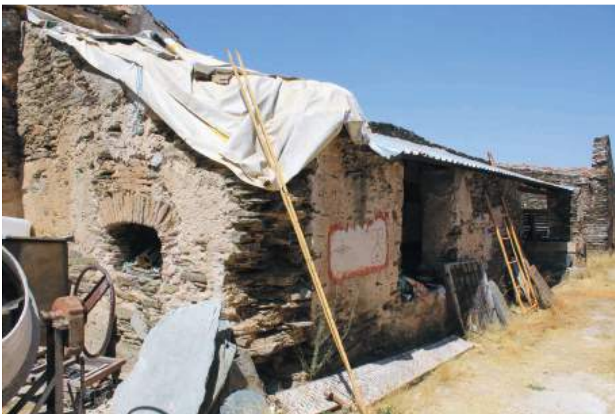
Lagar construido dentro de un corral.
