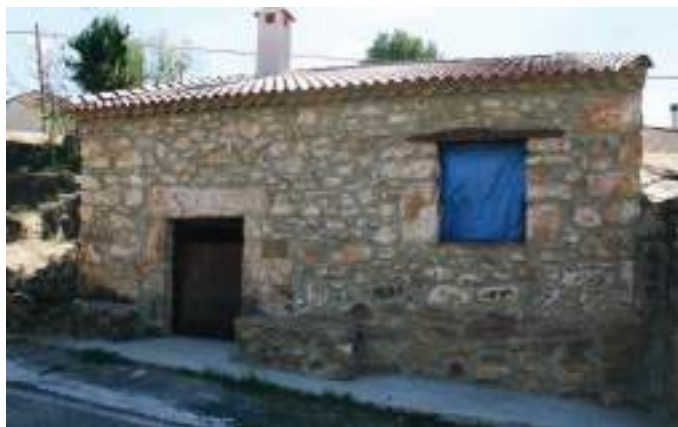
Torreadrada. Casilla de bodega.
