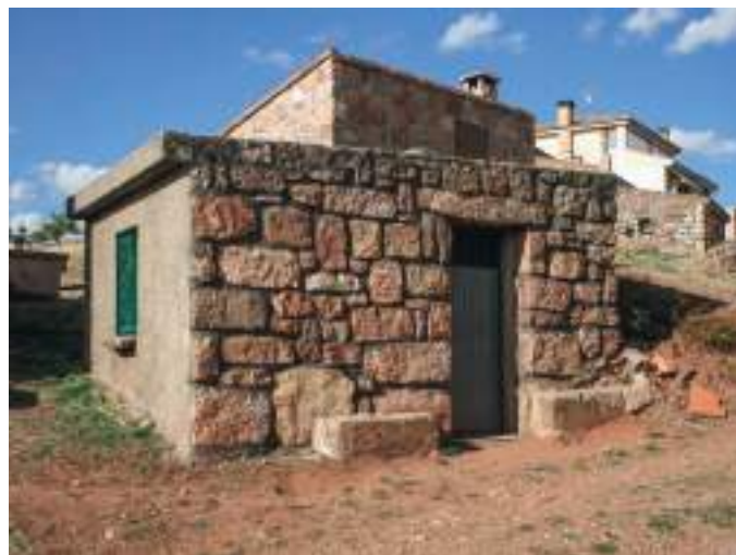
Casilla de techo plano reedificada.
