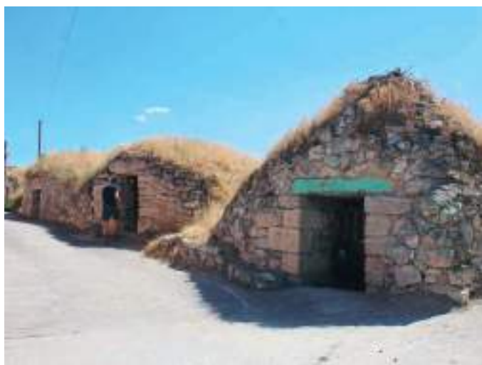
Bodegas del grupo oeste, en la calle Pedrejuela.
