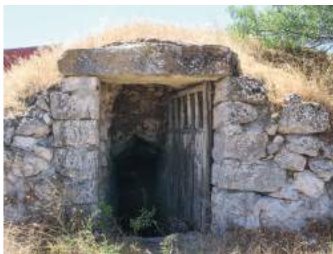
Entrada al lagar subterráneo.
