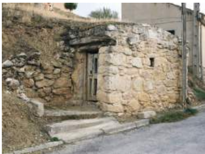
Bodega con contador.
