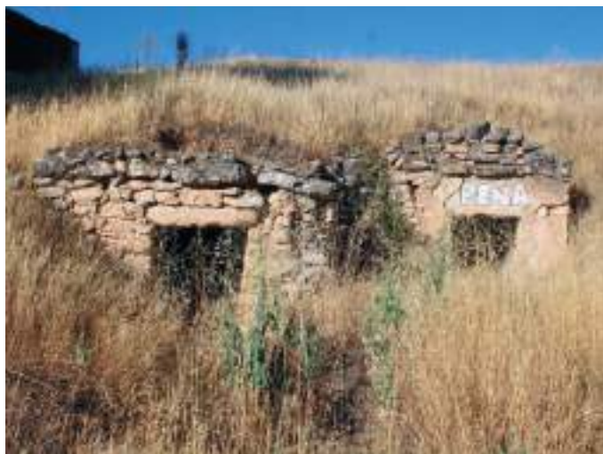
Bodegas construidas con sillarejo y mampostería.
