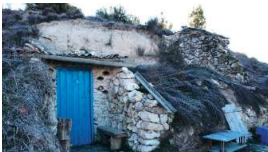
Bodega con fachada reconstruida.
