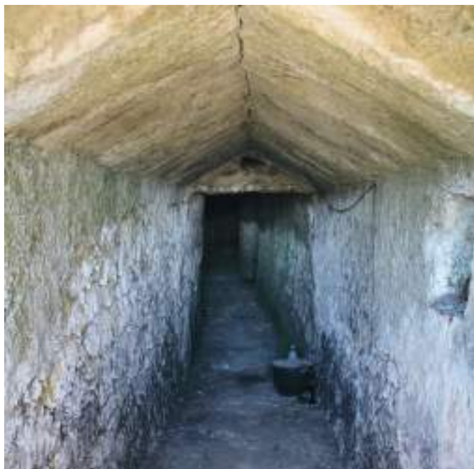
Cañón en horizontal con bóveda mitrada.
