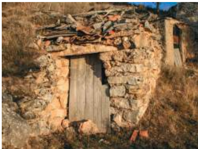
Bodega con contador.
