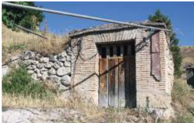
Fachada de ladrillo y entrada en codo.
