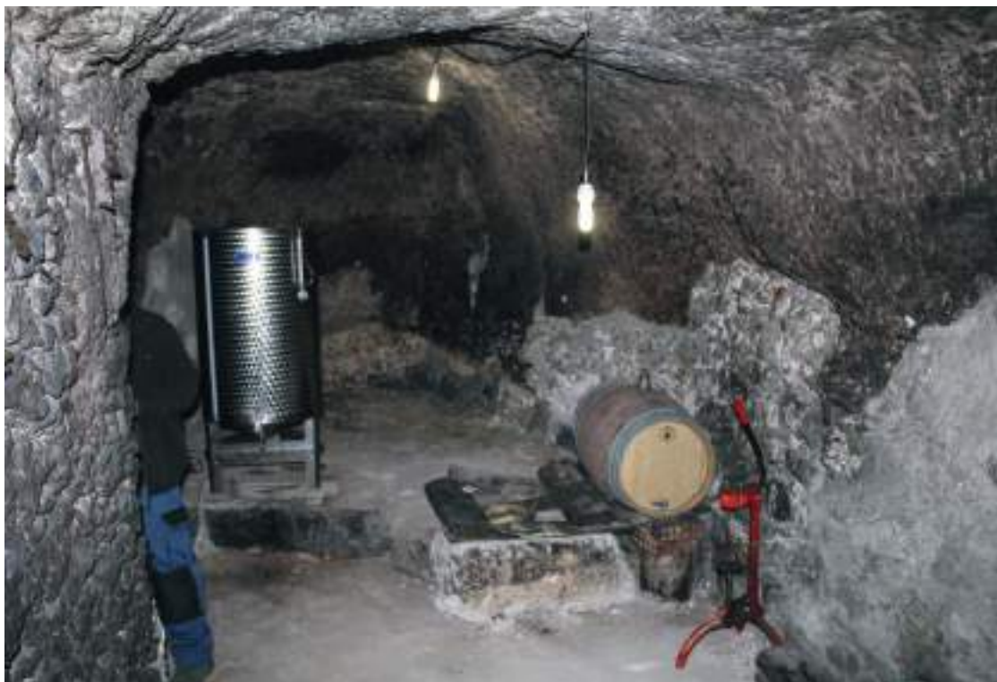
Nave de la misma bodega.
