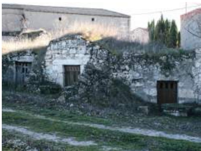
Vista parcial del barrio.
