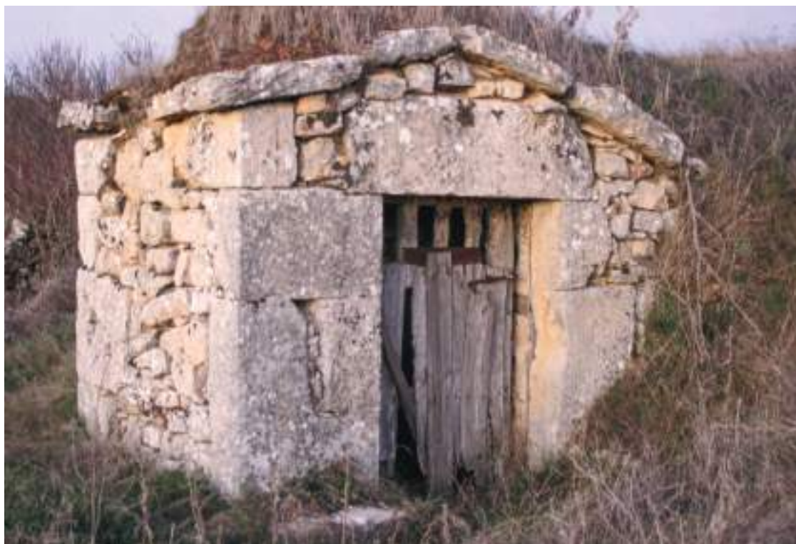
Bodega con contador para entrada en codo.
