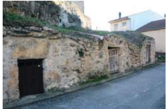
Torrecilla del Pinar. Bodegas dentro del núcleo urbano.
