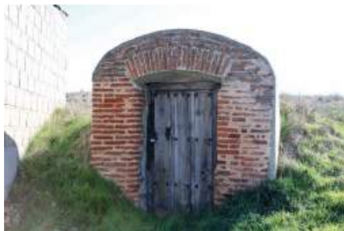
Fachada de bodega.
