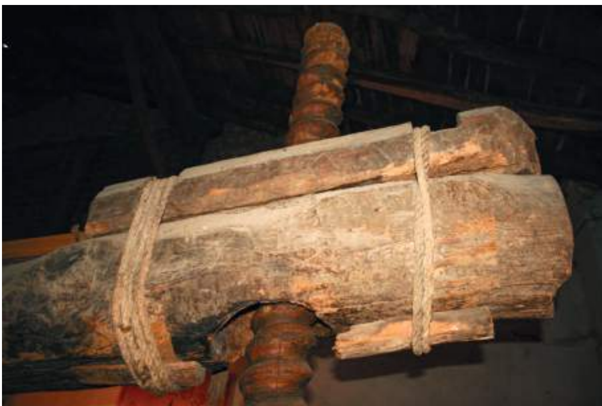
Entronque de la viga con el husillo, con la 'sapa' y los 'sobeos'.
