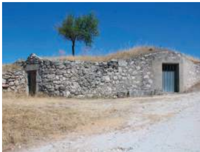
Bodegas del segundo grupo del este.
