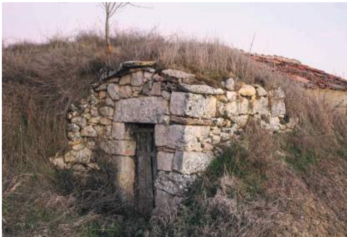
Bodega con contador para entrada en codo.
