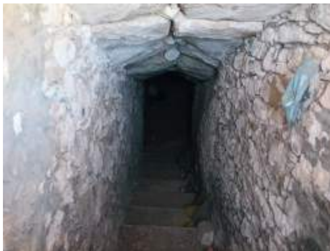
Bóveda de cañón mitrada, con las losas tendentes a la horizontalidad.
