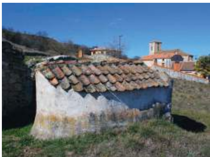
Descargadero de uva de lagar subterráneo.
