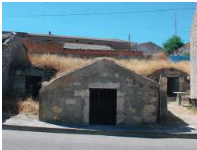
Bodegas del grupo del este, en la carretera.
