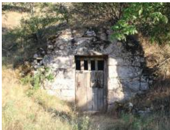
Fachada de bodega.
