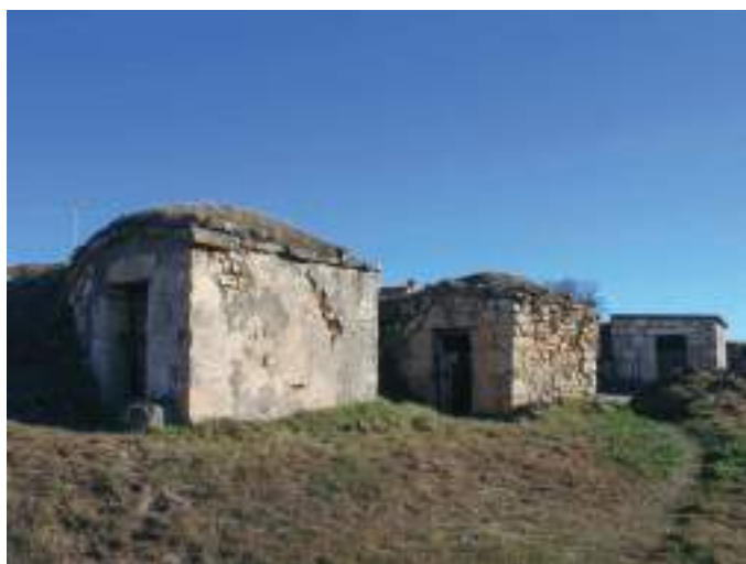
Bodegas con caseta-contador.
