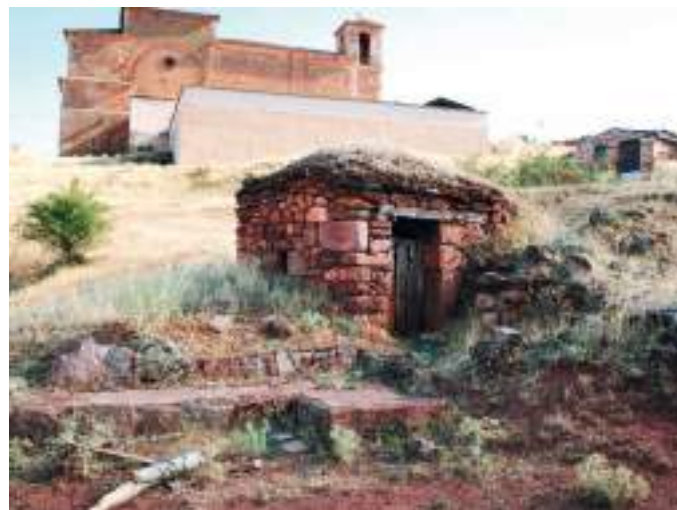
Bodega con contador.
