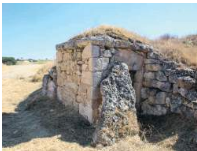
Bodega con caseta-contador.
