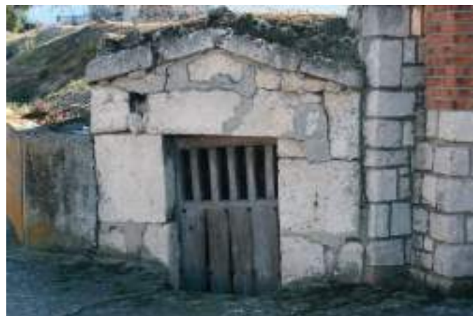
Bodega del grupo sur, con fachada simple.
