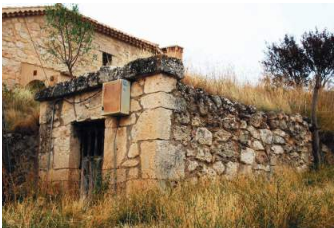
Fachada con alero horizontal y cañón desarrollado en superficie.
