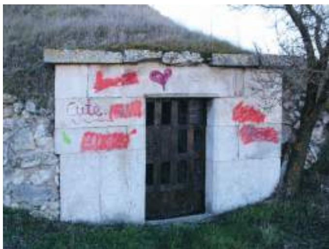
Bodega construida en 1902.
