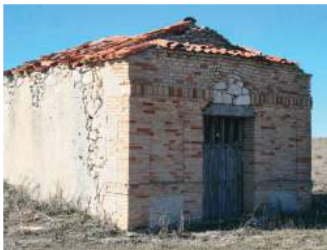
Bodega con fachada de ladrillo.
