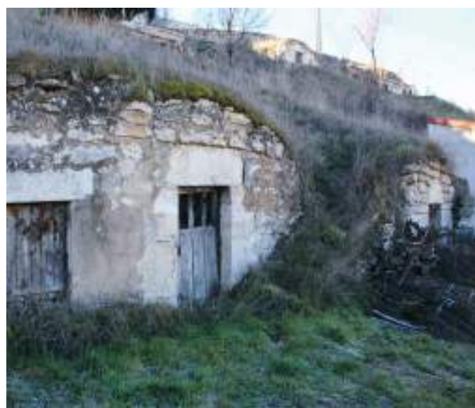
Probable lagar subterráneo con descargadero.
