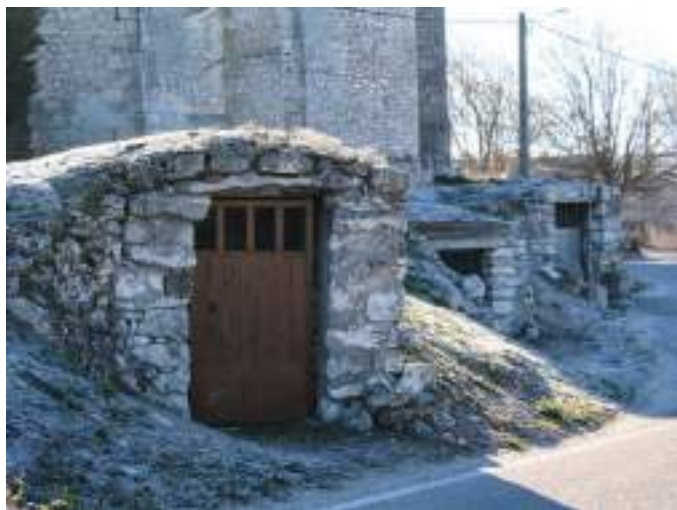
Bodegas con 'contador'.
