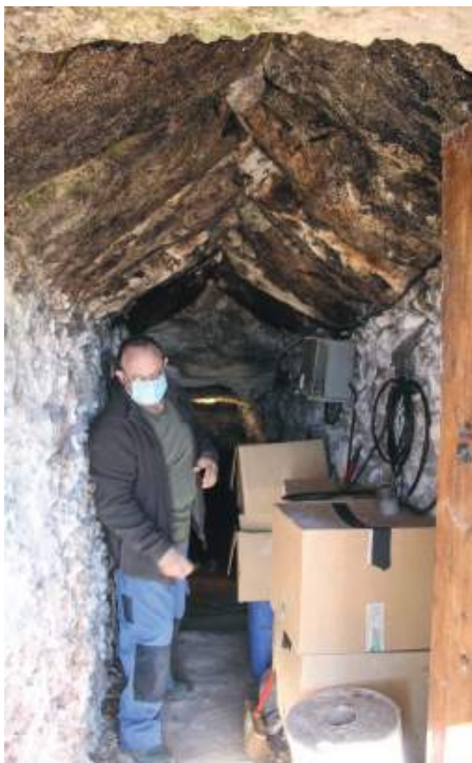
Primer tramo del cañón cubierto con bóveda mitrada en dicha bodega.
