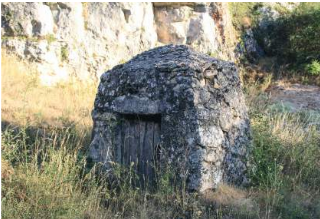
Descargadero de uva de lagar subterráneo.
