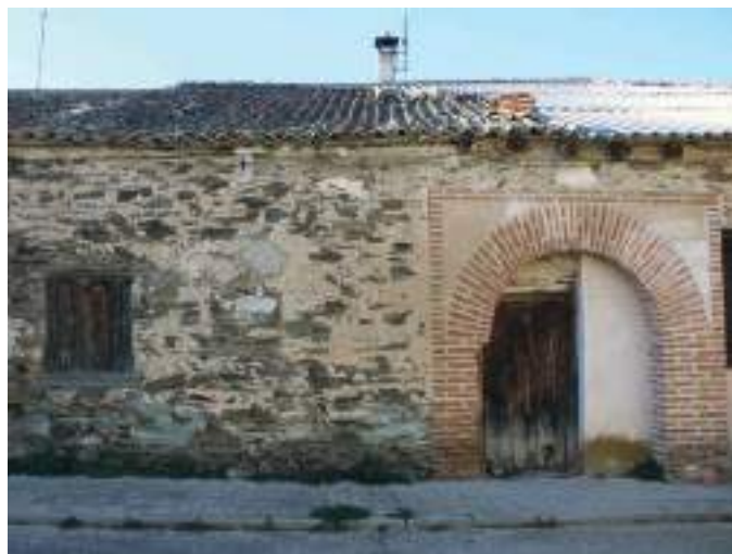
Fachada del lagar fechado en 1728.
