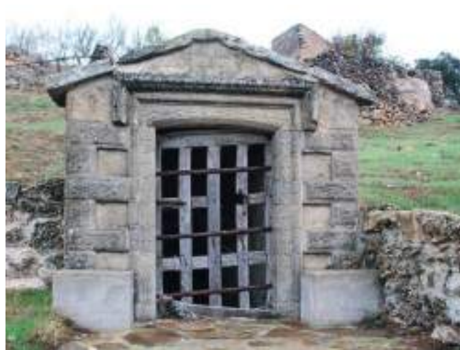
Fachada con materiales hechos con molde. Fechada en 1931.
