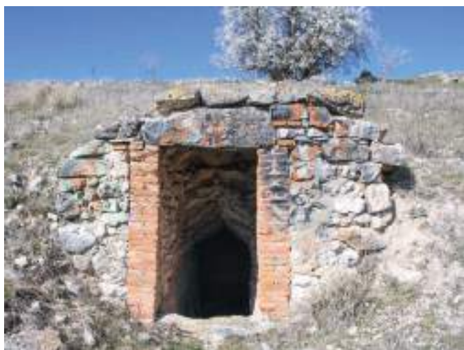
Fachada mixta de piedra y ladrillo.
