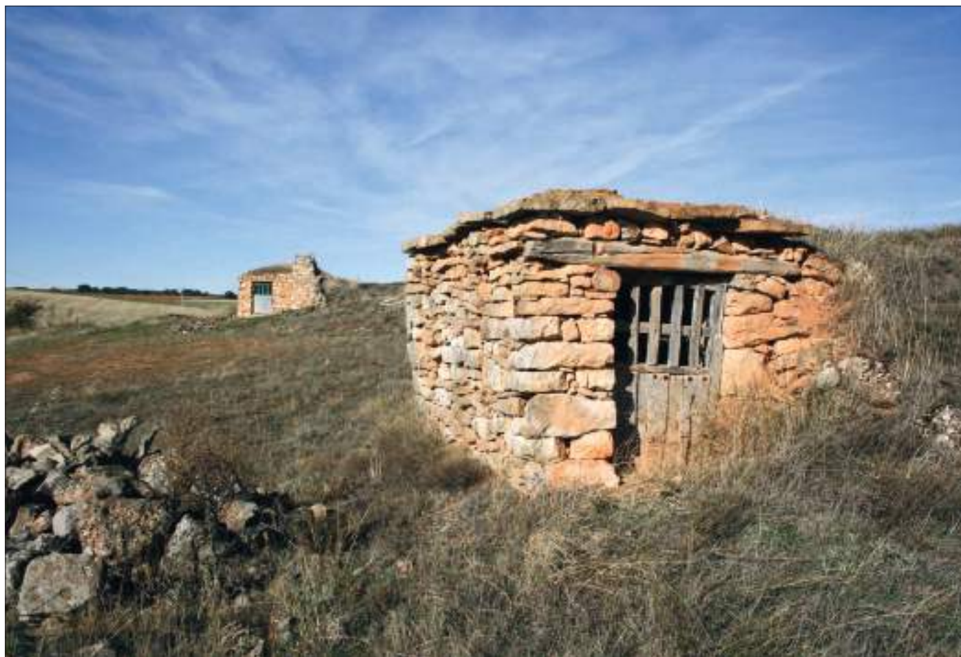
Bodegas con contador.
