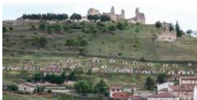
Fuentidueña. Bodegas en la ladera del castillo, alternancia de calizas y margas.
