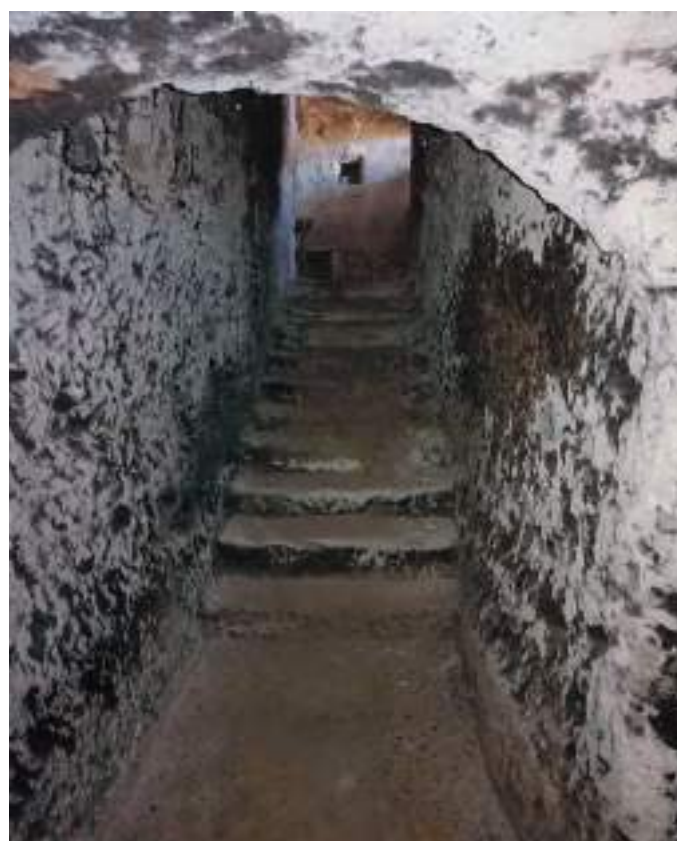
Cañón visto desde el interior de la bodega.
