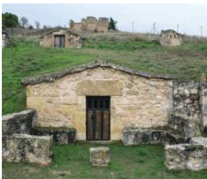
Bodega con antefachada y fachada de esquinas marcadas.
