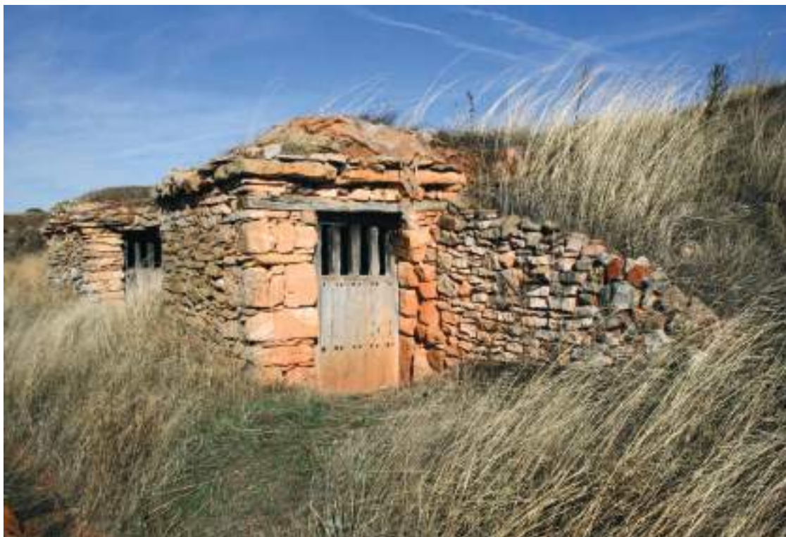
Bodegas con contador.
