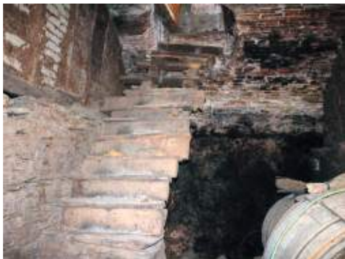
Interior de la bodega.
