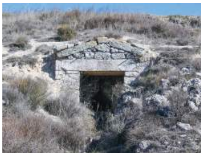
Bodega excavada en la ladera del páramo.
