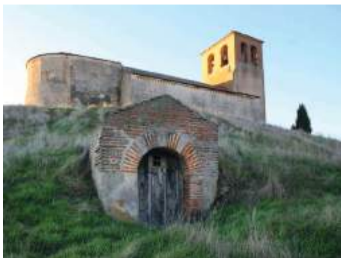
Fachada con puerta en arco.
