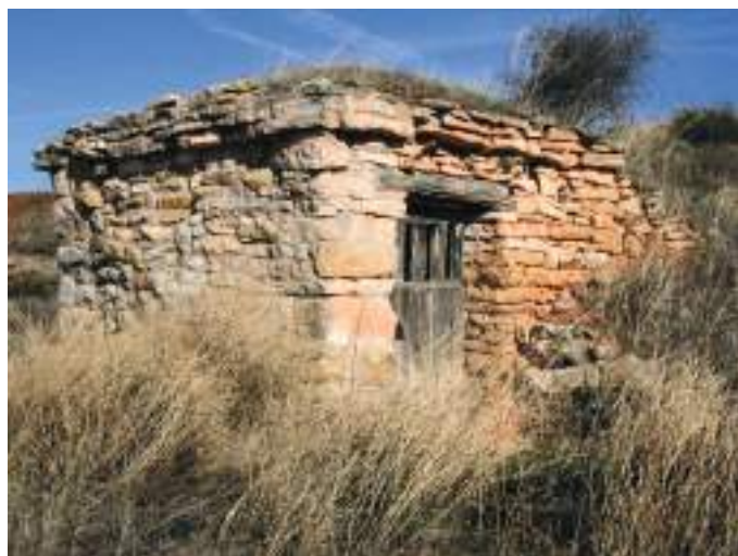
Contador de mampostería en hiladas y techo plano.
