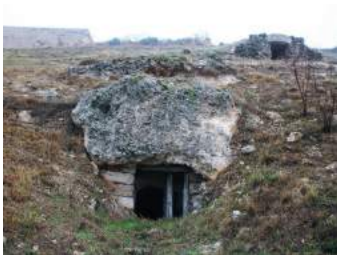
Bodega excavada bajo un afloramiento rocoso.
