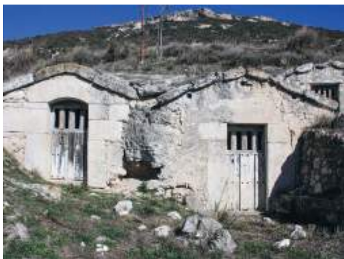
Dos fachadas semejantes. La de la izquierda construida probablemente en 1902.
