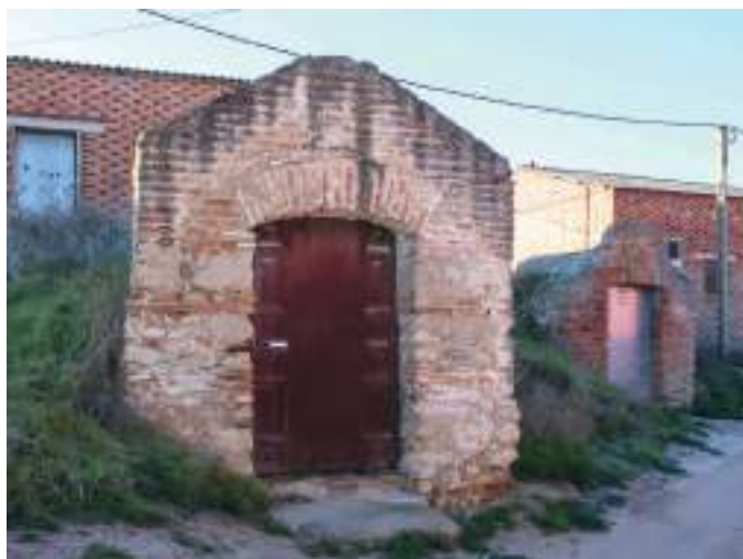
Fachada mixta de piedra y ladrillo.
