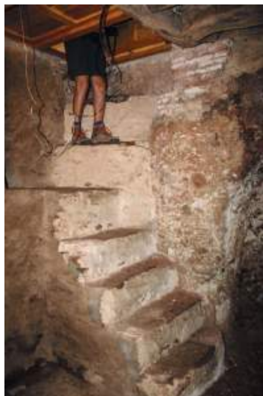
Escaleras bajo el suelo de la vivienda.
