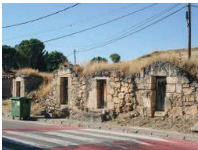
Bodegas en la carretera, con un solo frente de fachada.
