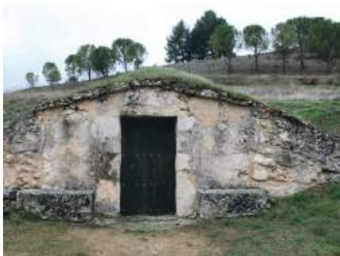
Portada recrecida para contener el terreno.
