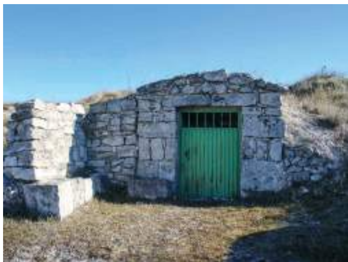
Bodega con 'antefachada'.
