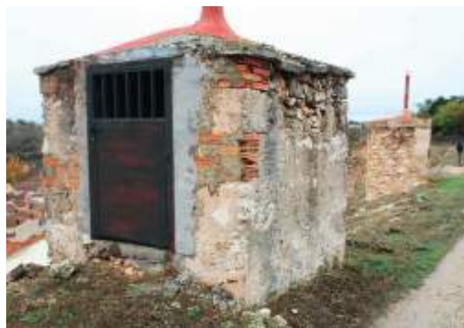
Descargaderos de uva reconvertidos en chimeneas para mendereros en el interior.
