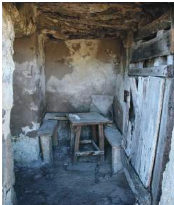
Interior de la caseta-contador.
