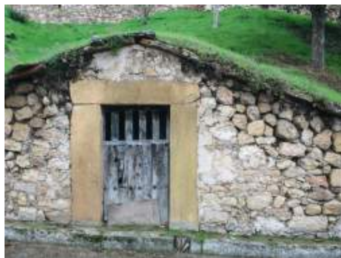
Ejemplo del empleo del sillar y de la mampostería.
