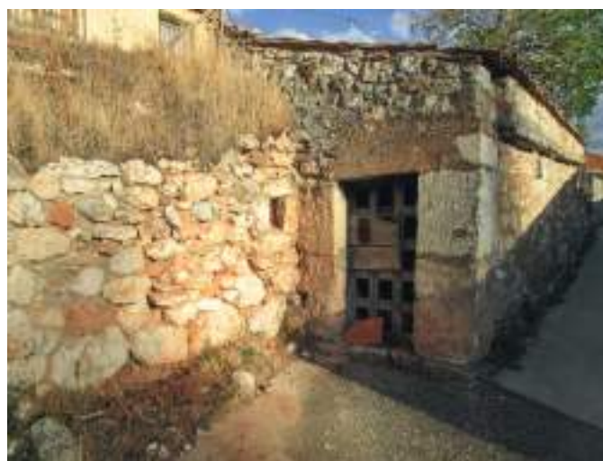
Casilla de bodega.
