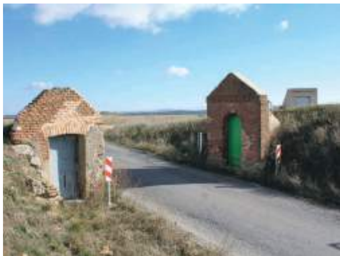
Bodegas con fachadas originales.
