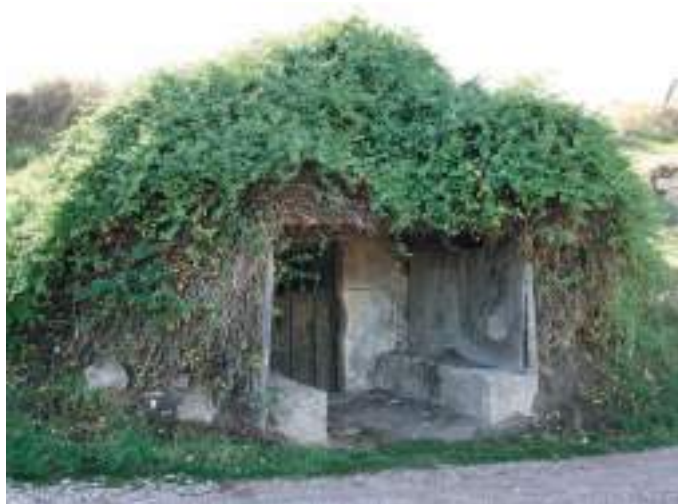
Bodega con antefachada muy desarrollada.
