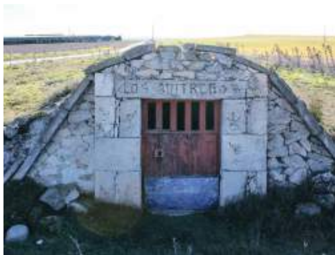
Bodega construida probablemente en 1901.
