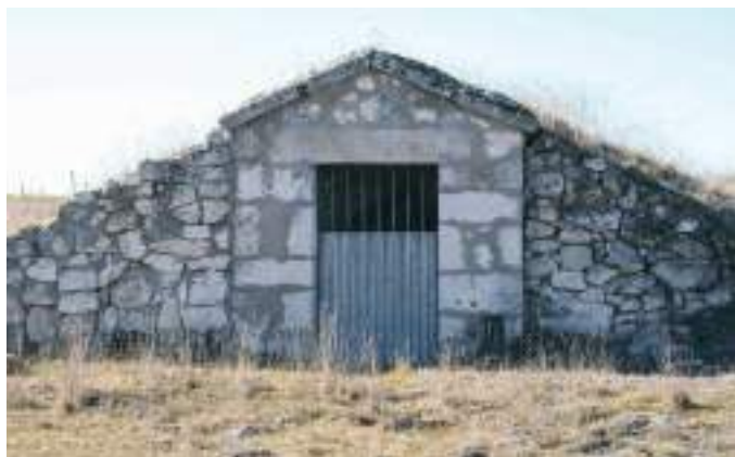
Vegafría. Fachada prolongada con muretes laterales.
