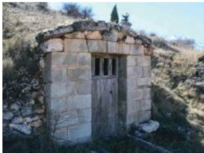
Fachada construida con materiales fabricados con molde.
