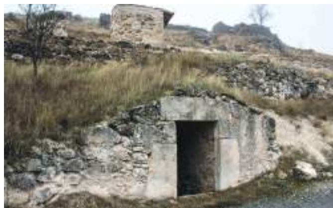
Valtiendas. Fachada de lagar subterráneo, con fecha de 1871, y descargadero de uva construido por encima.
