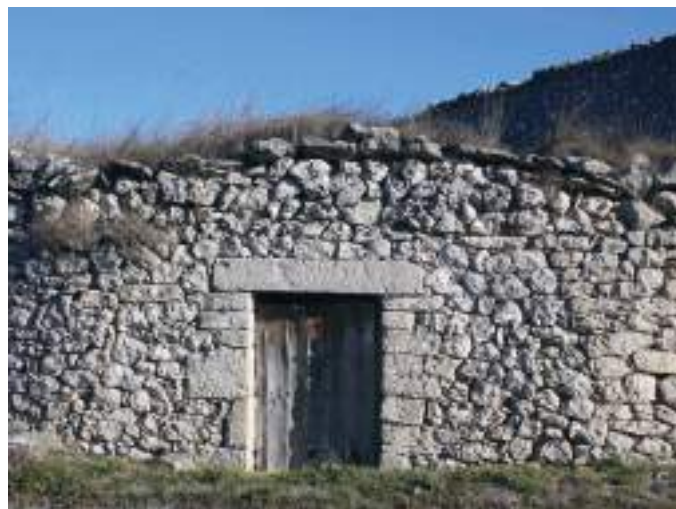
Detalle de fachada.
