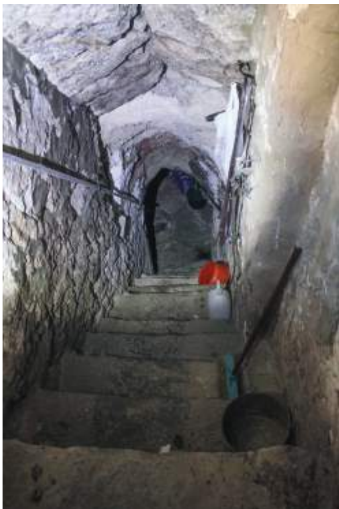
Cañón con bóveda mitrada y paredes reforzadas.
