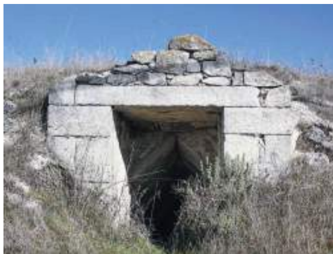
Bodega con espacio adintelado y bóveda mitrada.
