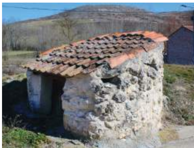
Descargadero de uva de lagar subterráneo.
