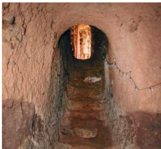
Cañón visto desde el interior de la bodega.
