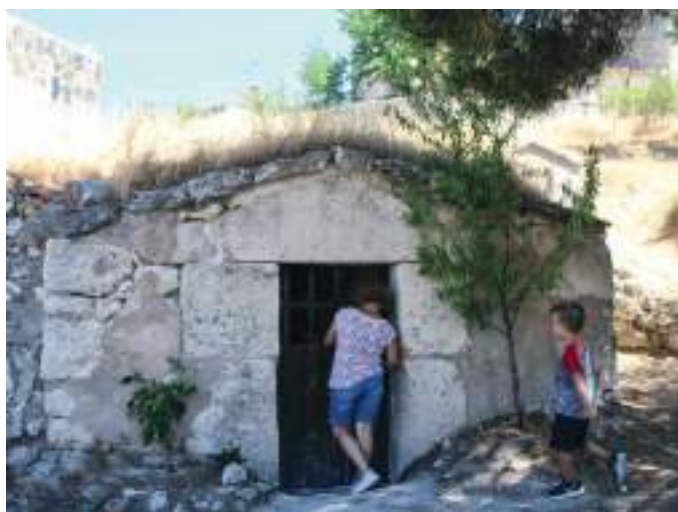
Bodega con fachada prolongada.
