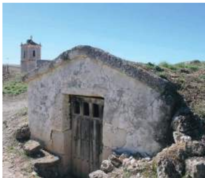
Fachada rematada en frontón.
