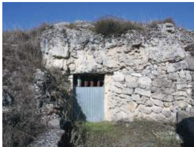
Bodega excavada y cubierta en estrato rocoso.
