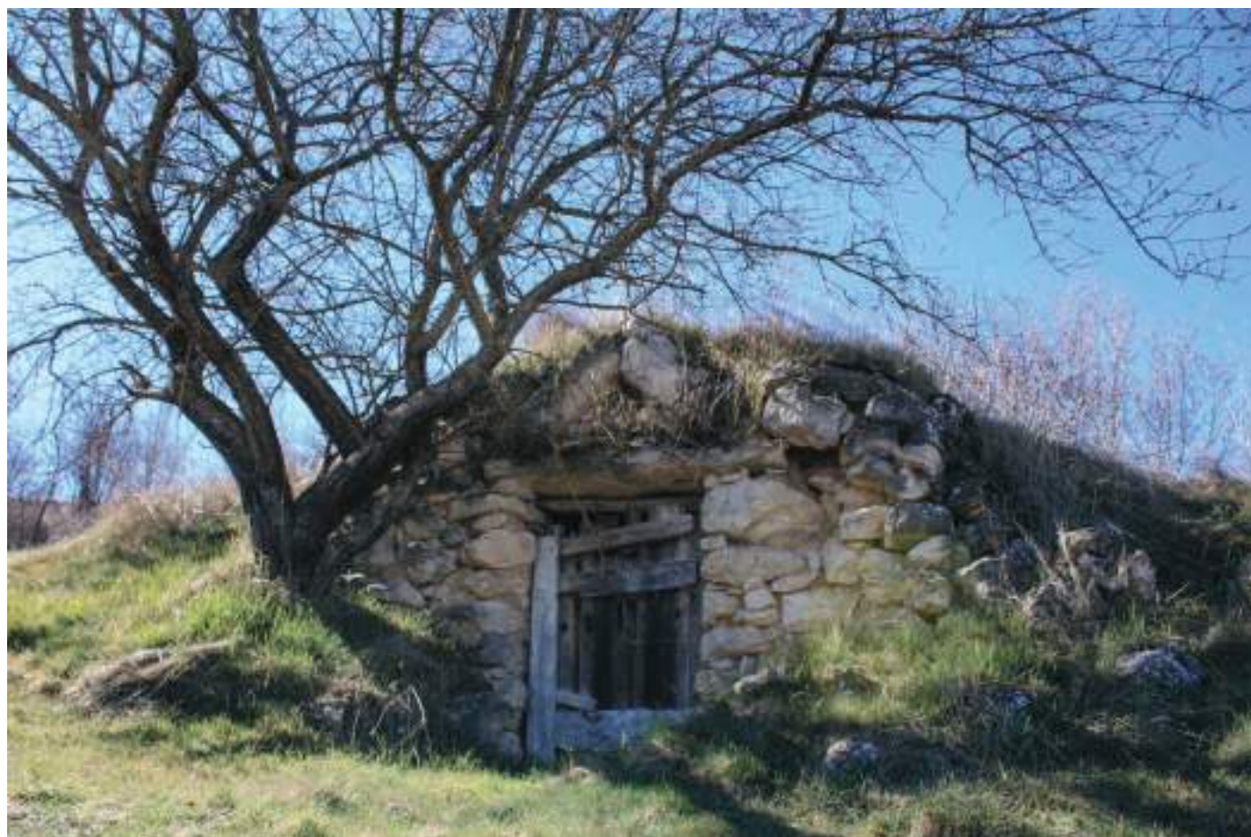
Fachada que sigue la curvatura del lomo de la bodega.
