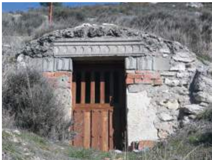
Fachada que emplea diferentes materiales en su construcción.
