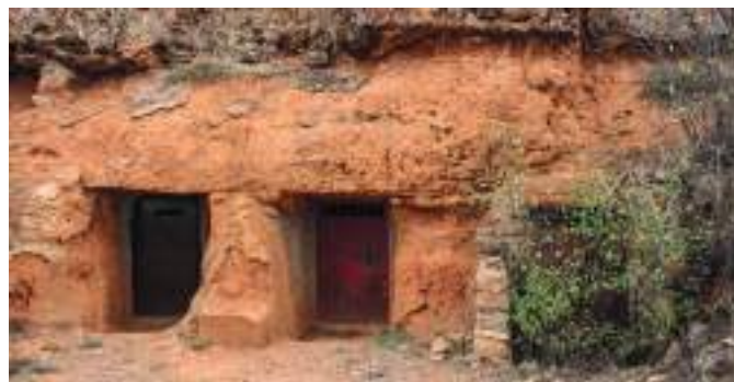
Ayllón. Bodegas excavadas en las arcillas bajo las rocas de arenisca.
