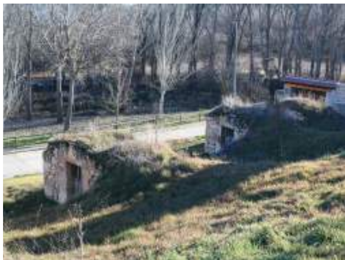
Bodegas con contador.
