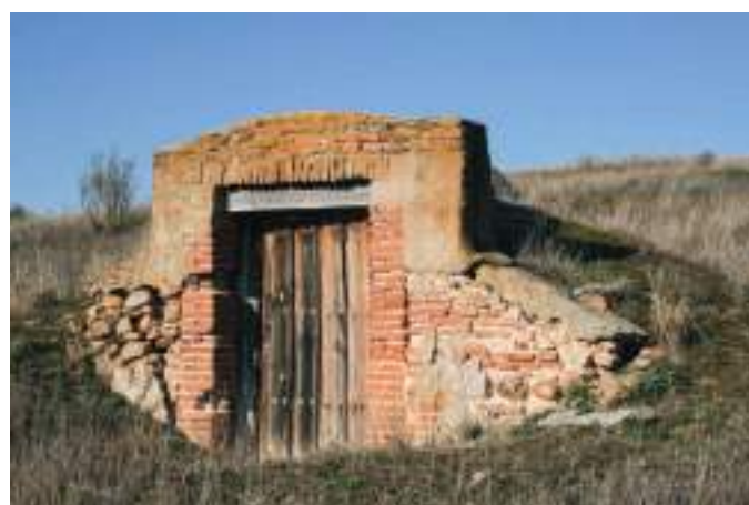
Fachada simple con muretes para sujetar la tierra.
