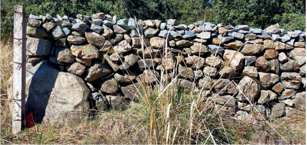
FIG. 108. Pared coronada con mampuestos de pequeño tamaño y sin uso de cobijas. Como puede observarse por el contraste en la coloración de las dos hileras del remate con respecto al resto del cercado, se trata de una rehabilitación reciente. Fuente: elaboración propia.
