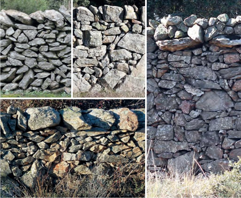
FIG. 106. Diferentes remates con sistemas de cobijas en paredes de Pedraza, El Espinar, Navas de Riofrío y (a la derecha) en la cerca de la finca del Palacio Real de Riofrío. *Fuente:* elaboración propia.
