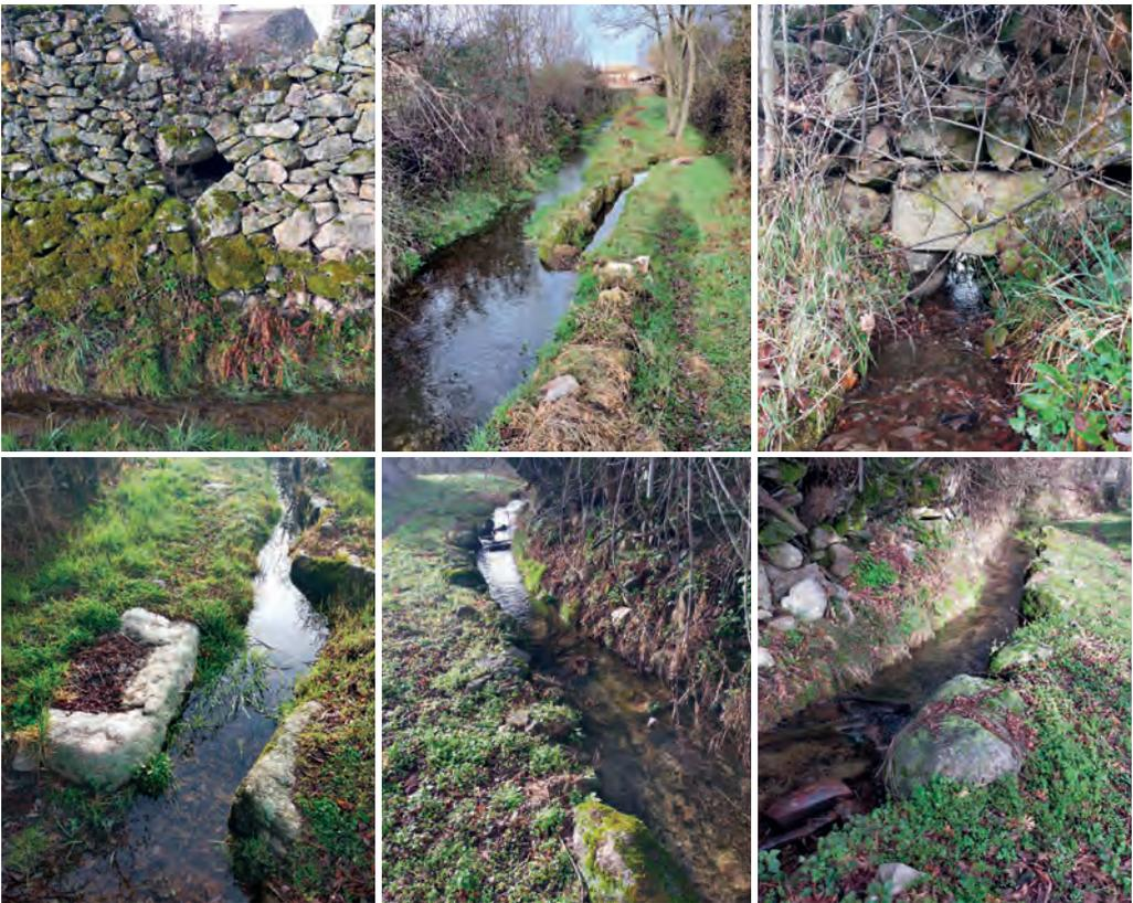
FIG. 24. Diferentes usos *menores* de la piedra en un pequeño tramo de la cacera de Ceguilla (Aldealengua de Pedraza). De izquierda a derecha y de arriba a abajo: a) muro de contención de piedra en seco cuyo drenaje contribuye al caudal de la acequia; b) sistema de repartición; c) hornillo de acceso de la acequia a una finca cercada; d), e) y f) localización estratégica de piedras de considerable porte en curvas y articulaciones. Fuente: elaboración propia.
