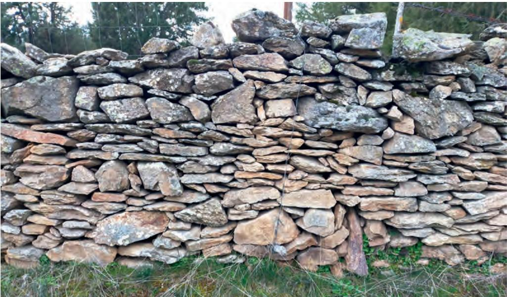
FIG. 117. Pared de lascas o lapas encamadas, en Pedraza. Fuente: elaboración propia.
