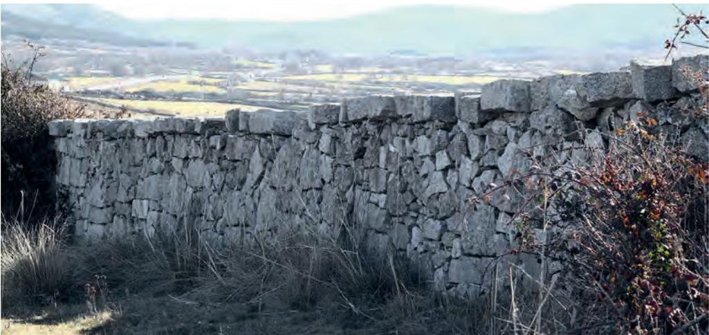
FIG. 107. Remate de pared realizado con cobijas de granito labradas en El Espinar. *Fuente:* elaboración propia.
