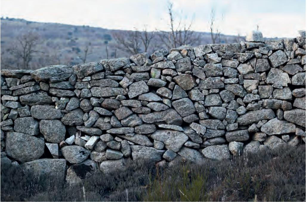
FIG. 60. Detalle de la estupenda pared de piedra en seco que compone el cerramiento de la Dehesa Chica de El Espinar (MUP n.º 143). Construida bajo licencia real en 1725. Fuente: elaboración propia.
