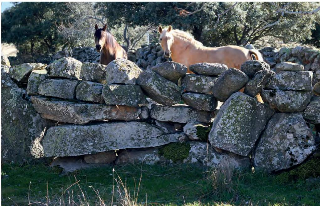
FIG. 99. Pared sencilla de mampuestos de piedra centenera de gran dimensión, en La Losa. *Fuente*: elaboración propia.
