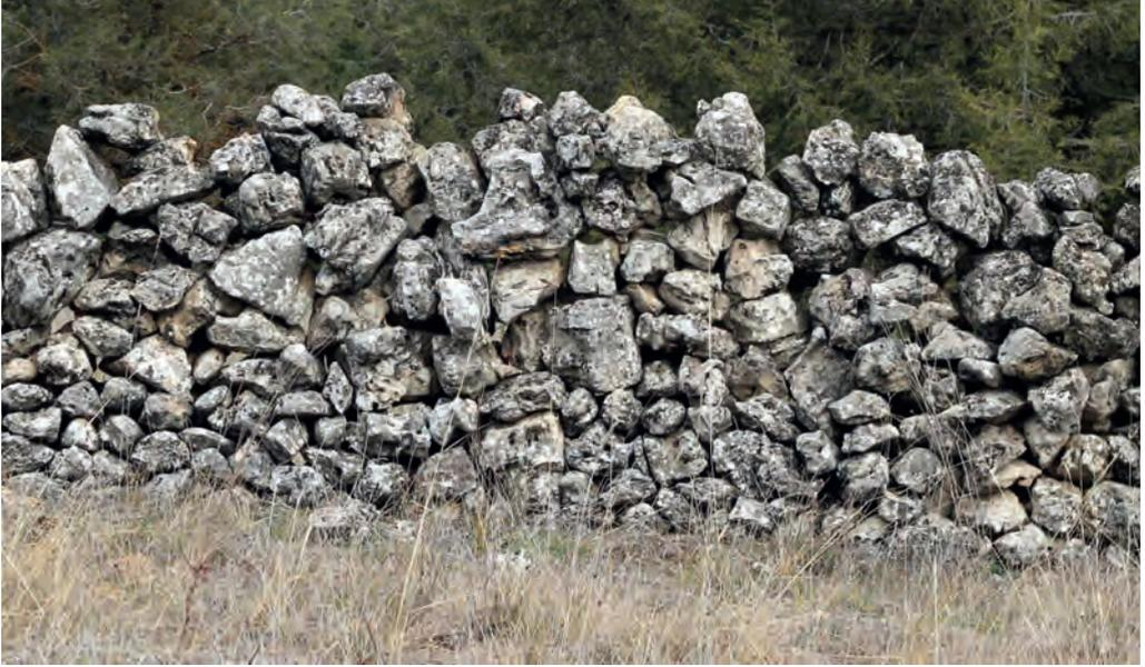
FIG. 131. Pared mixta de piedra triguera (caliza), en Casla. En la zona inferior la pared se compone de dos hojas de mampuestos de pequeño tamaño; a medida que sube en altura, y en contra de lo que resulta habitual en las paredes dobles, los mampuestos pasan a ser de mayor tamaño y a configurar una única hoja. *Fuente:* elaboración propia.
