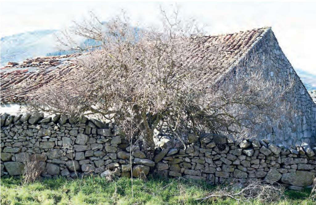
FIG. 139. Pared de granito parcialmente derribada por el crecimiento descontrolado de un roble integrado en ella, en El Espinar. Fuente: elaboración propia.
