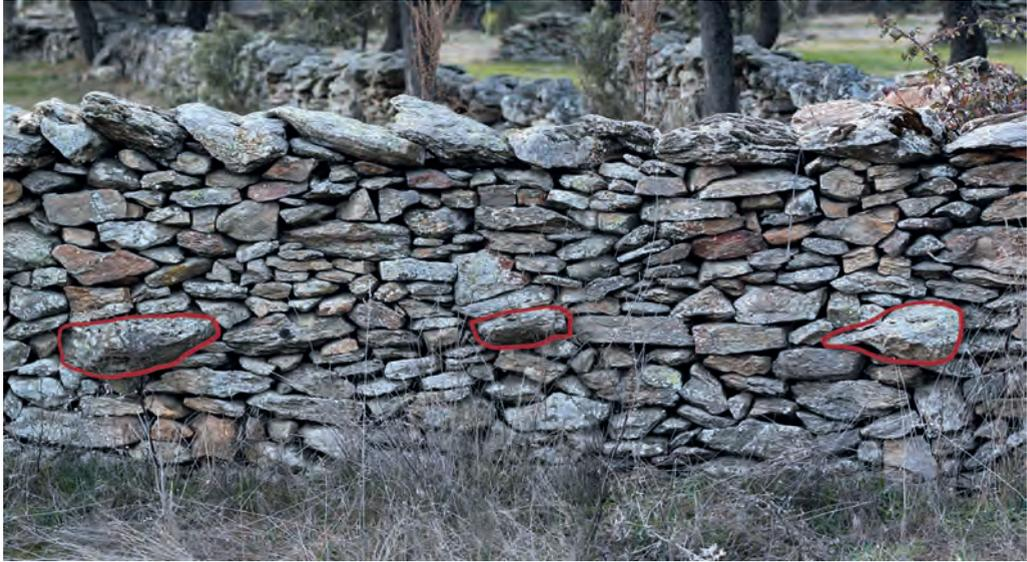
FIG. 103. Ubicación de pasaderas en una pared de Rades de Abajo (Pedraza). Fuente: elaboración propia.
