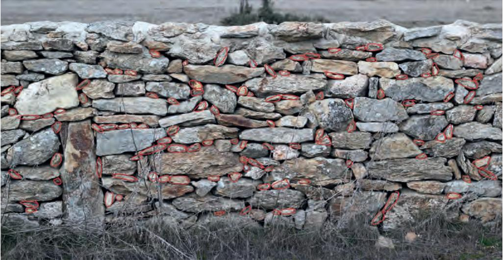
FIG. 115. Identificación de los ruchos (en rojo) en una pared «bien enruchadita» de Rades de Abajo (Pedraza). Fuente: elaboración propia.
