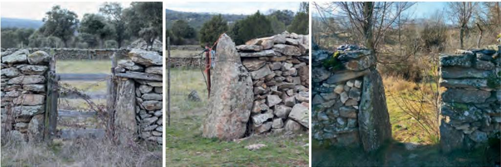
FIG. 111. Esquinas de paredes en Rades de Abajo (Pedraza) y en Cañicosa (Matabuena) rematadas por medio de llaves. *Fuente:* elaboración propia.
