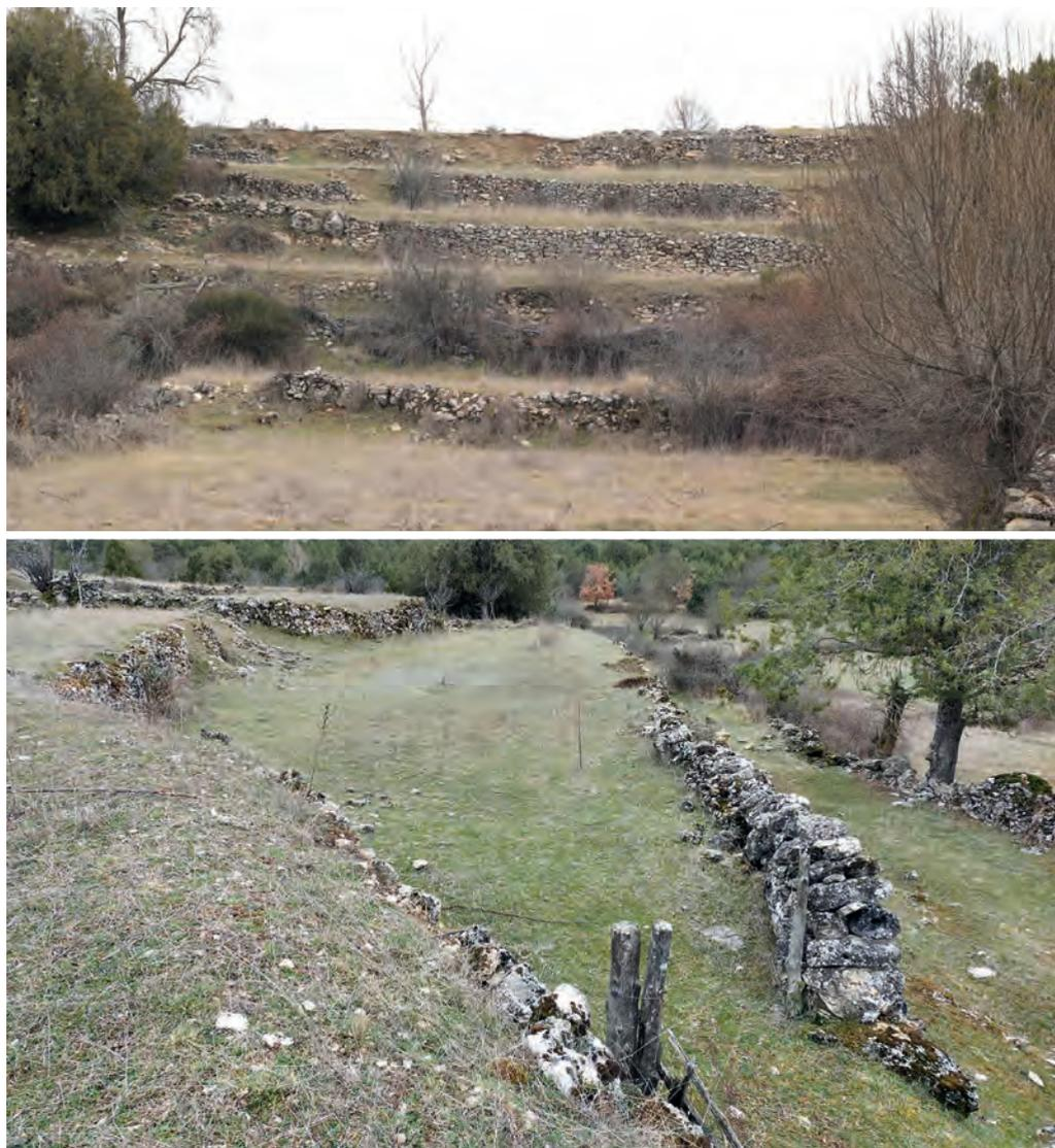
FIG. 148. Aterrazamiento de pastos mediante muros de piedra en seco, en Casla. *Fuente:* elaboración propia.
