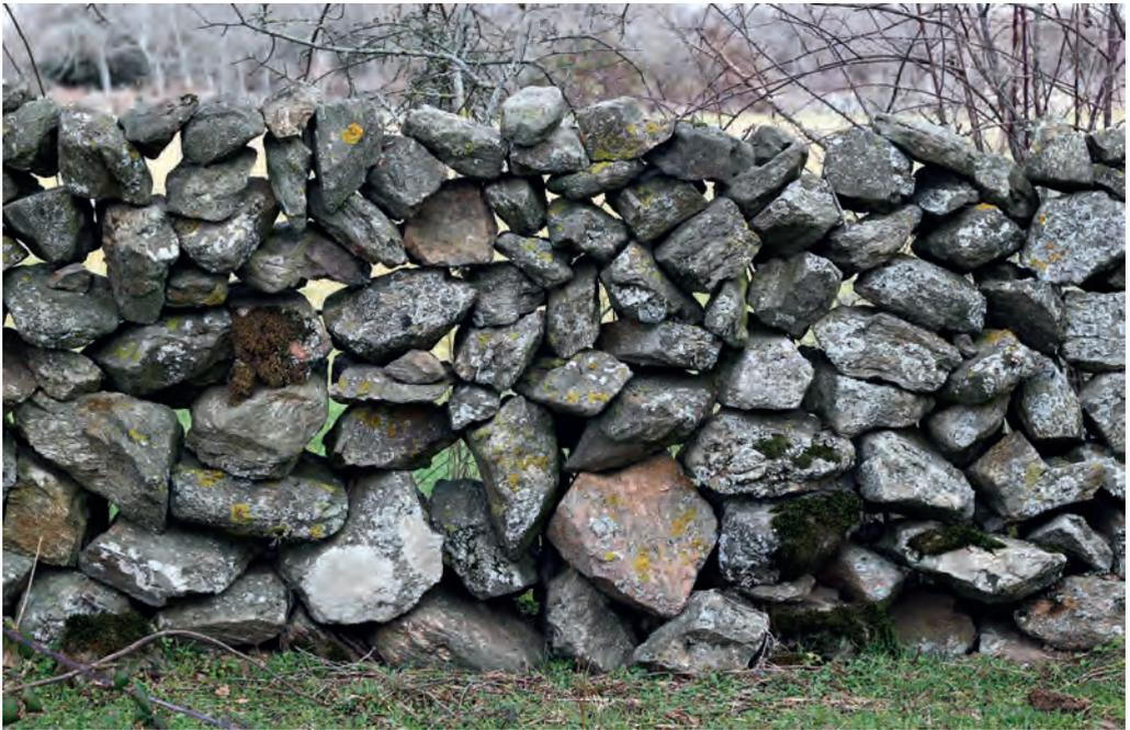
FIG. 98. Pared sencilla de mampuestos de piedra centenera de medio porte, en Revenga. Nótese la gran dimensión de los huecos. *Fuente:* elaboración propia.
