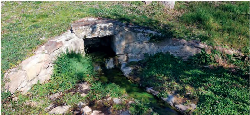
FIG. 29. Uso de morteros de cemento en la restauración de la fuente del Acebo, en Revenga. Fuente: elaboración propia.
