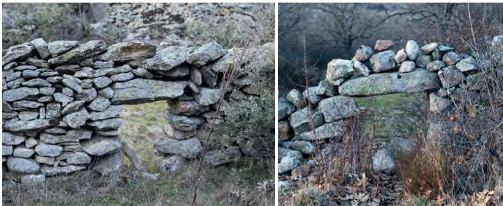
FIG. 134. Hornillos para el paso de animales en Rades de Abajo (Pedraza) y en El Espinar. Fuente: elaboración propia.
