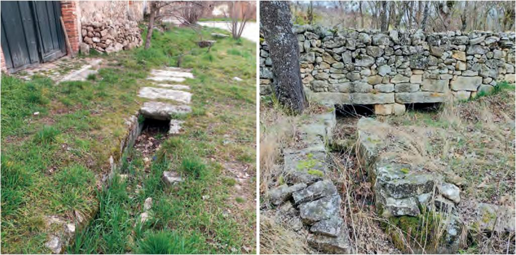
FIG. 23. Uso de la piedra en la canalización de acequias: a) Cabanillas del Monte; b) Matamala. Fuente: elaboración propia.
