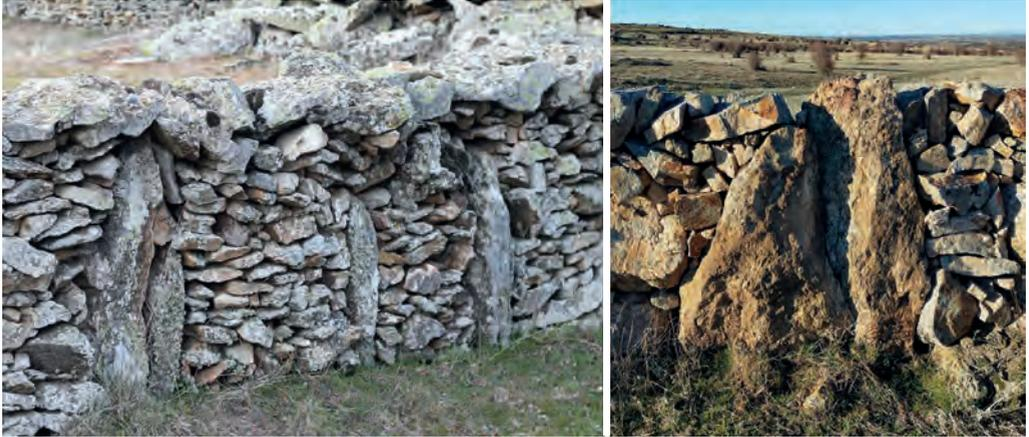
FIG. 112. Llaves y casillares en paredes de Rades de Abajo y de Torrecaballeros. Fuente: elaboración propia.
