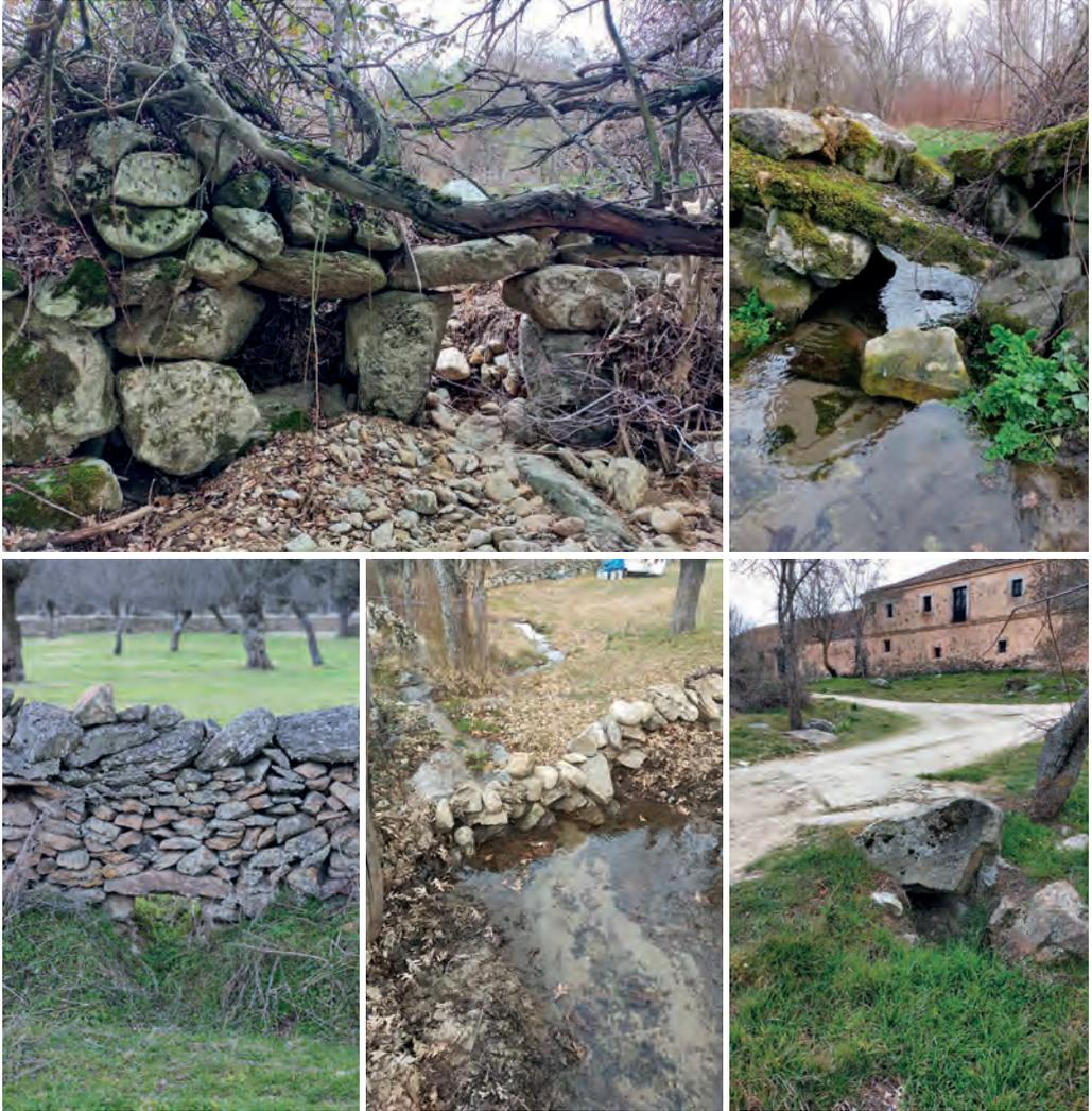
FIG. 21. Ejemplos de *hornillos* y pasos de agua de piedra en seco. De izquierda a derecha y de arriba a abajo: a) Matabuena; b) Arcones; c) Pedraza; d) Ortigosa del Monte; y e) Cabanillas del Monte. Fuente: elaboración propia.
