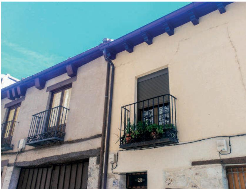
*Renovación de acabados en viviendas tradicionales en Cuéllar. En primer plano, con mortero monocapa con base de cemento (fisurado) y en segundo plano con mortero de cal. Fuente: el autor. Fecha: junio 2015*
