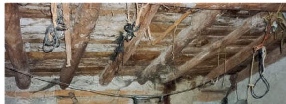
Estructura horizontal de vivienda "pudiente" (arriba- Lovingos), con madera aserrada con escuadrías importantes, zapatas y herrajes metálicos; y estructura horizontal de vivienda de "labradores" (abajo- Membibre de la Hoz) con rollizos de madera. Fuente: el autor. Fecha: 2015
