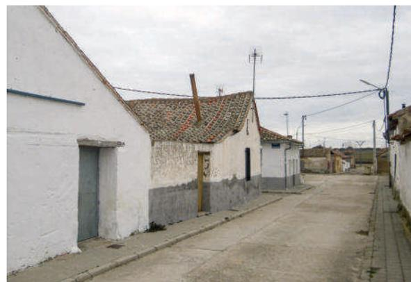
Arriba, revestimiento de cal esgrafiado imitando sillares, zócalos, esquinas y dinteles. Abajo, revestimiento de cal con zócalo más oscuro para tratar de ocultar el verdín y el chapoteo. Ambos ejemplos en Muñopedro, con fábrica de adobe como muro portante. Fuente: el autor. Fecha: julio 2014
