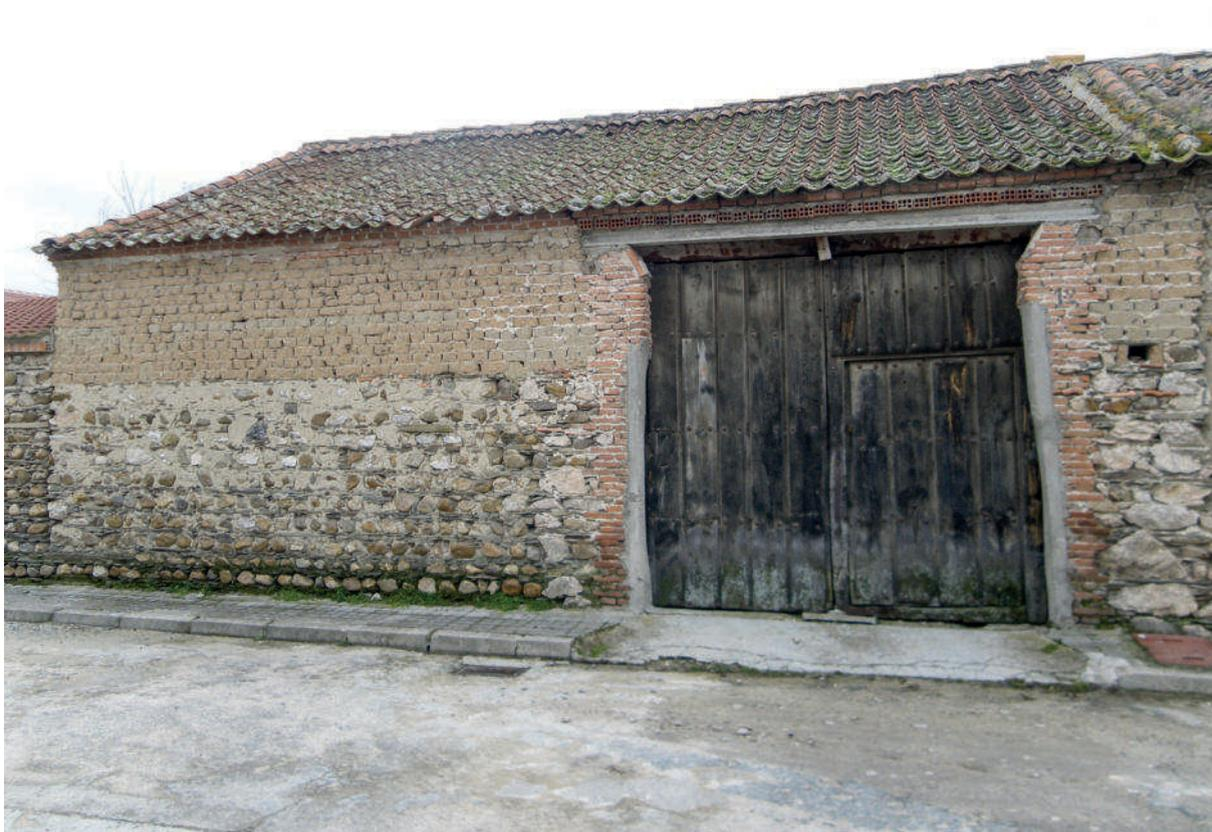
*Construcción auxiliar en Juarros de Voltoya con zócalo de hiladas de canto rodado y lajas de pizarra, y paramento superior de fábrica de adobe. Fuente: el autor. Fecha: diciembre 2014*
