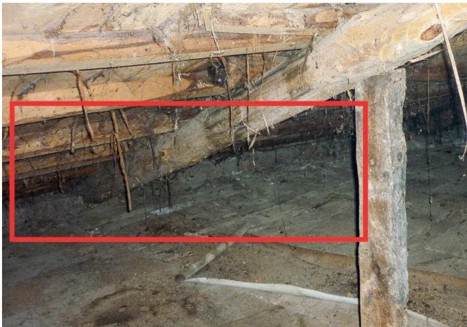
*Apoyo de pares de cubierta sobre durmiente de madera (en rojo) en cabeza del muro de fachada. Vivienda en Sepúlveda. Fotografía: el autor. Fecha: noviembre 2014*
